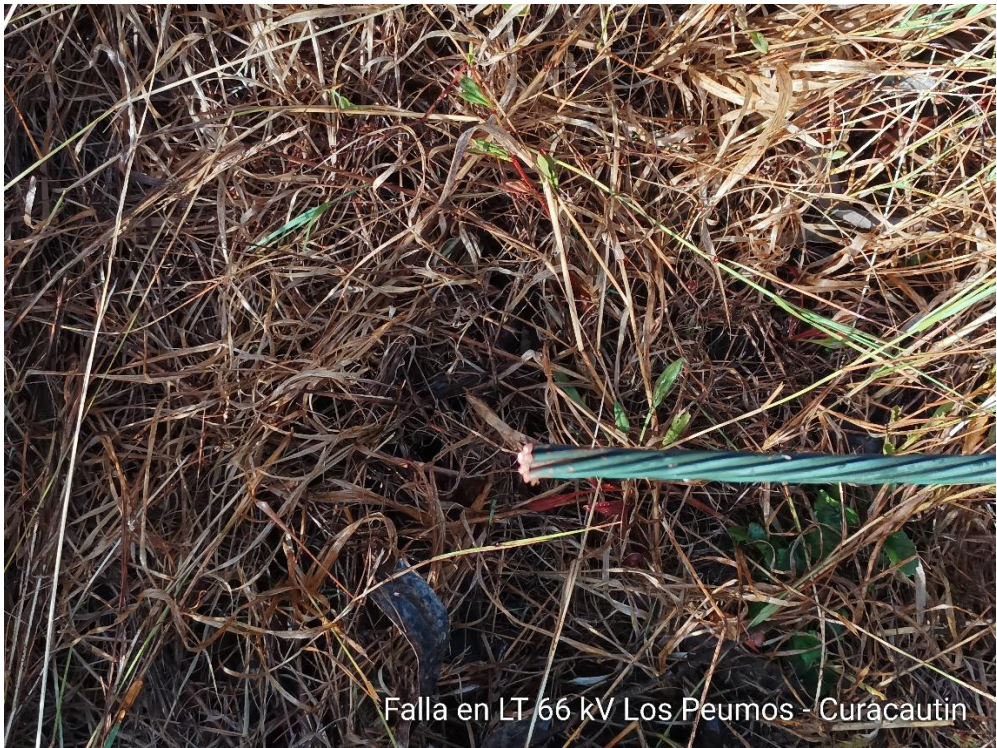
Fotografía N°2. Se muestra corte intensional de los cables robados.
