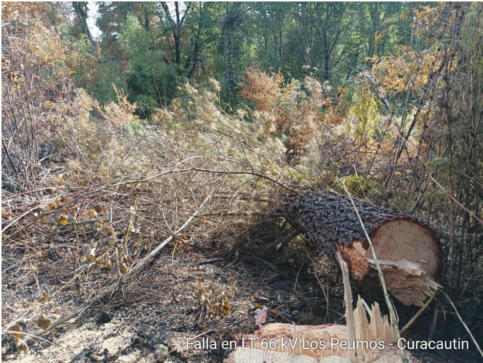
Fotografía N°1. Se muestra árbol derribado intencionalmente por terceros en el vano E88 – E89
