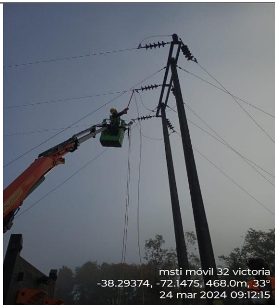
DURANTE INSTALACIÓN DE TIERRAS
