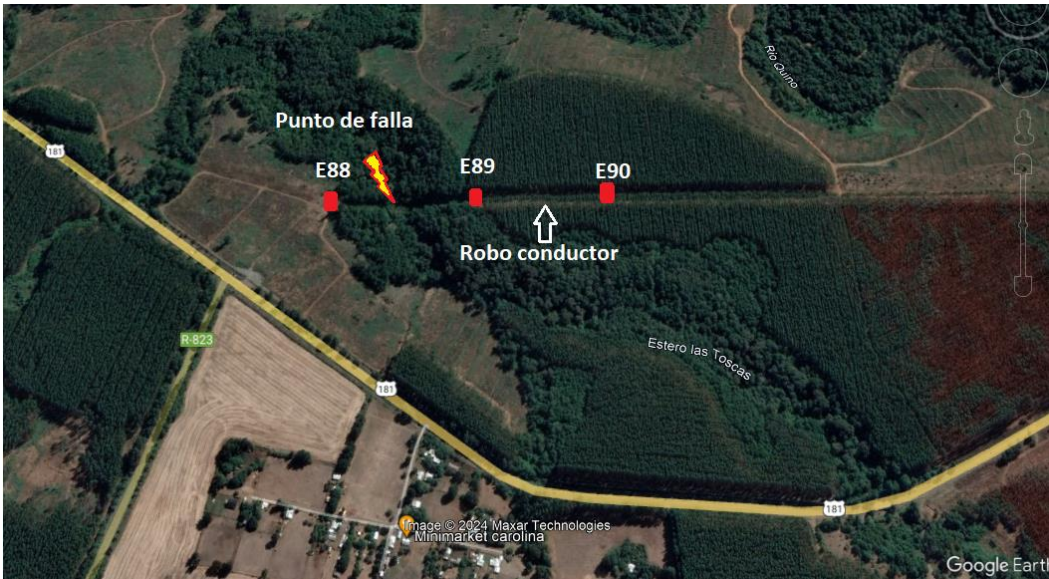
Figura 1.- Se muestra imagen referencial de la zona donde se produjo la falla y el robo de conductor.
