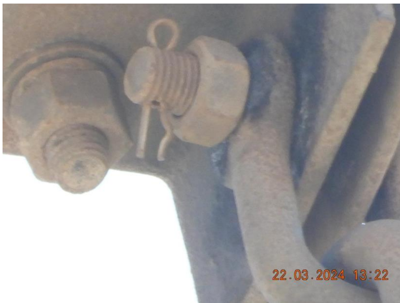
Imagen N°3: Fase inferior izquierda Estructura N°84, inspección a nivel de piso.
