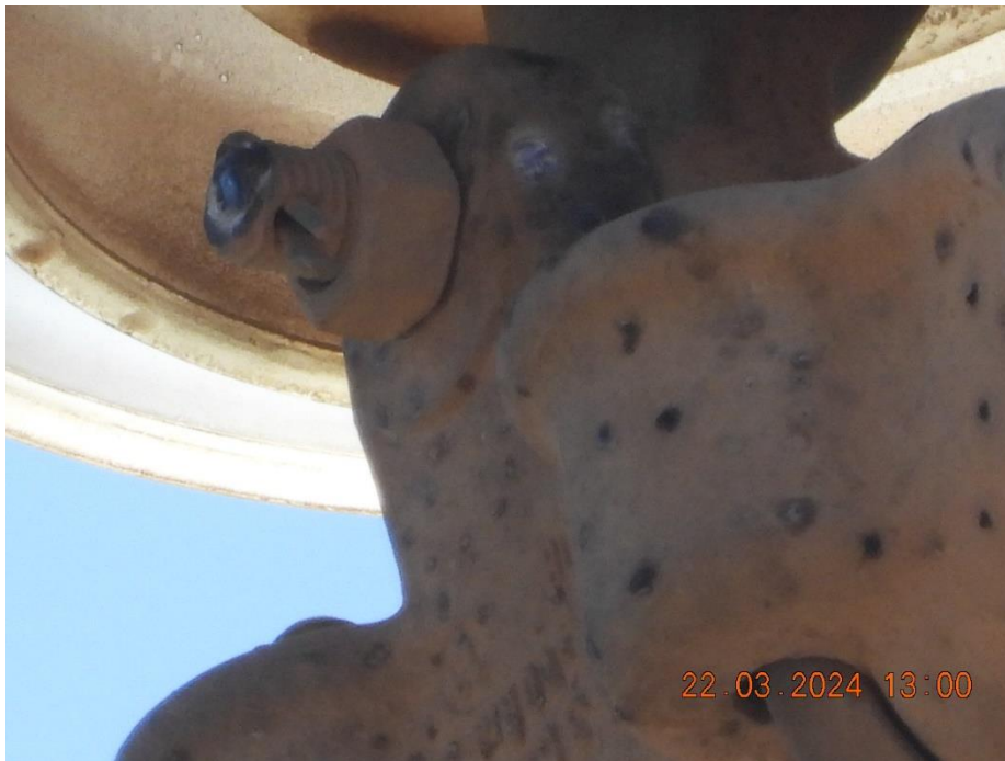
Imagen N°2: Fase inferior izquierda Estructura N°84, inspección a nivel de piso.
