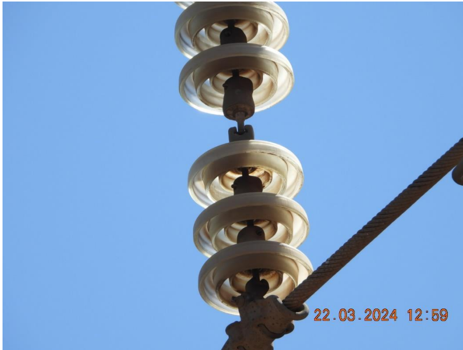
Imagen N°1: Fase inferior izquierda Estructura N°84, inspección a nivel de piso.
