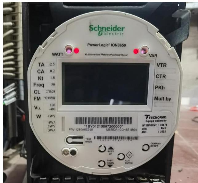
Figura 9.11 – Equipo medidor ION 8650 – Potencia bruta U1
