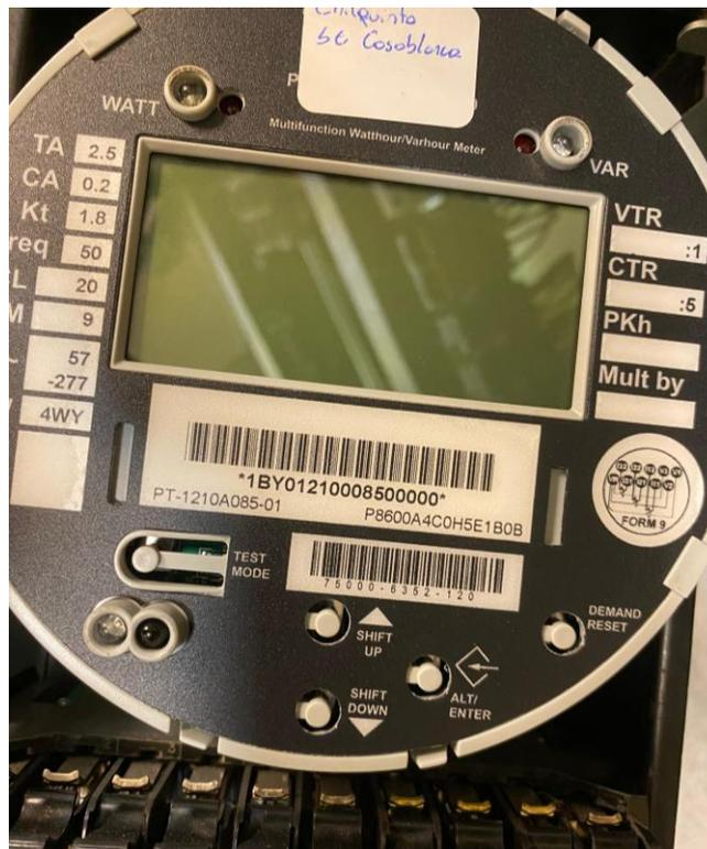
Figura 9.21 – Equipo medidor ION 8600 – Potencia neta U2
