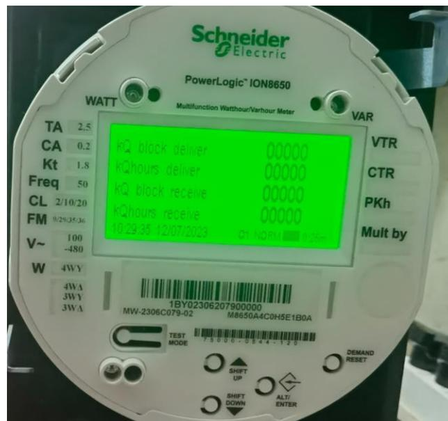
Figura 9.15 – Equipo medidor ION 8650 – Potencia bruta U3
