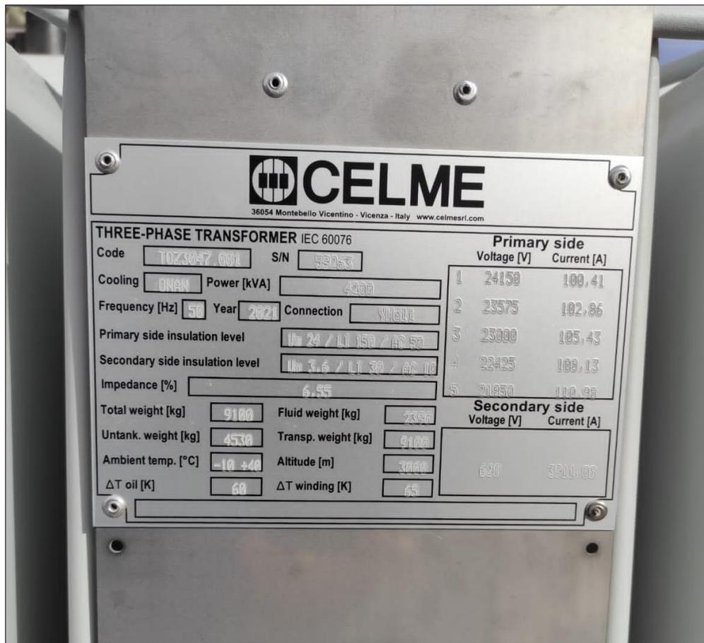
Figura 9.3: Placa del transformador de bloque
