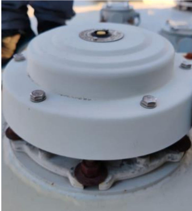
Figura 2 Testigo de operación por sobrepresión, no activado
