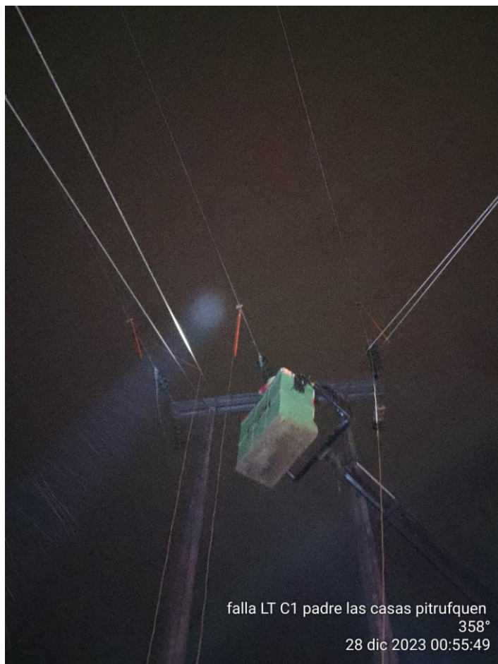
Imagen N°2: Faenas de reparación conductor cortado
