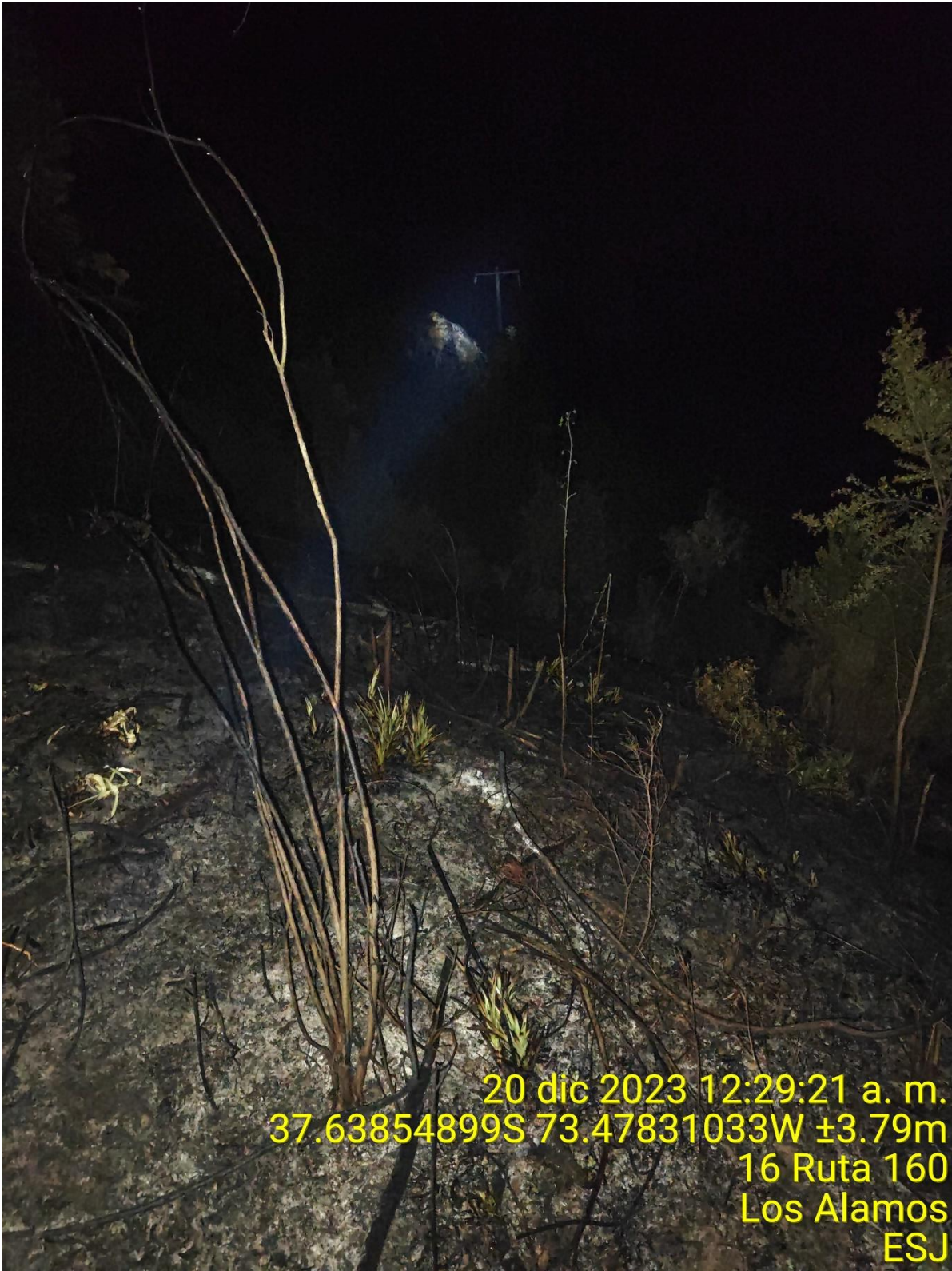
Fotografía N° 7: Vista entre las estructuras 516 y 517 en la línea LT Tres Pinos-Lebu.
