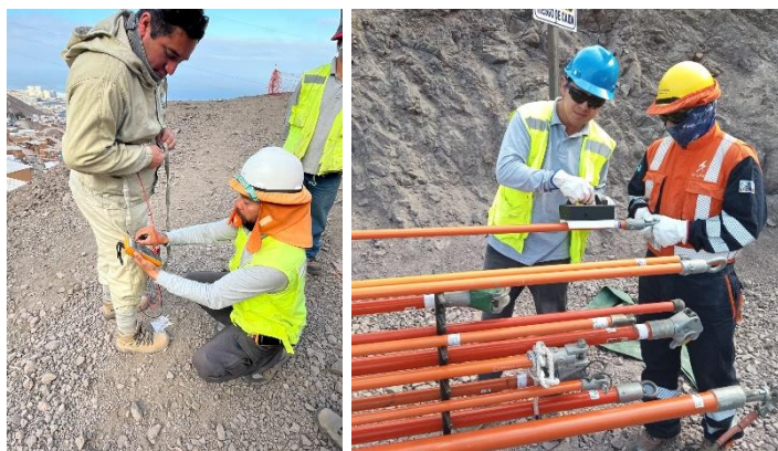
Figura 8: Muestra de certificaciones de equipos y pruebas de campo realizadas a elementos de trabajo previo a cada jornada
