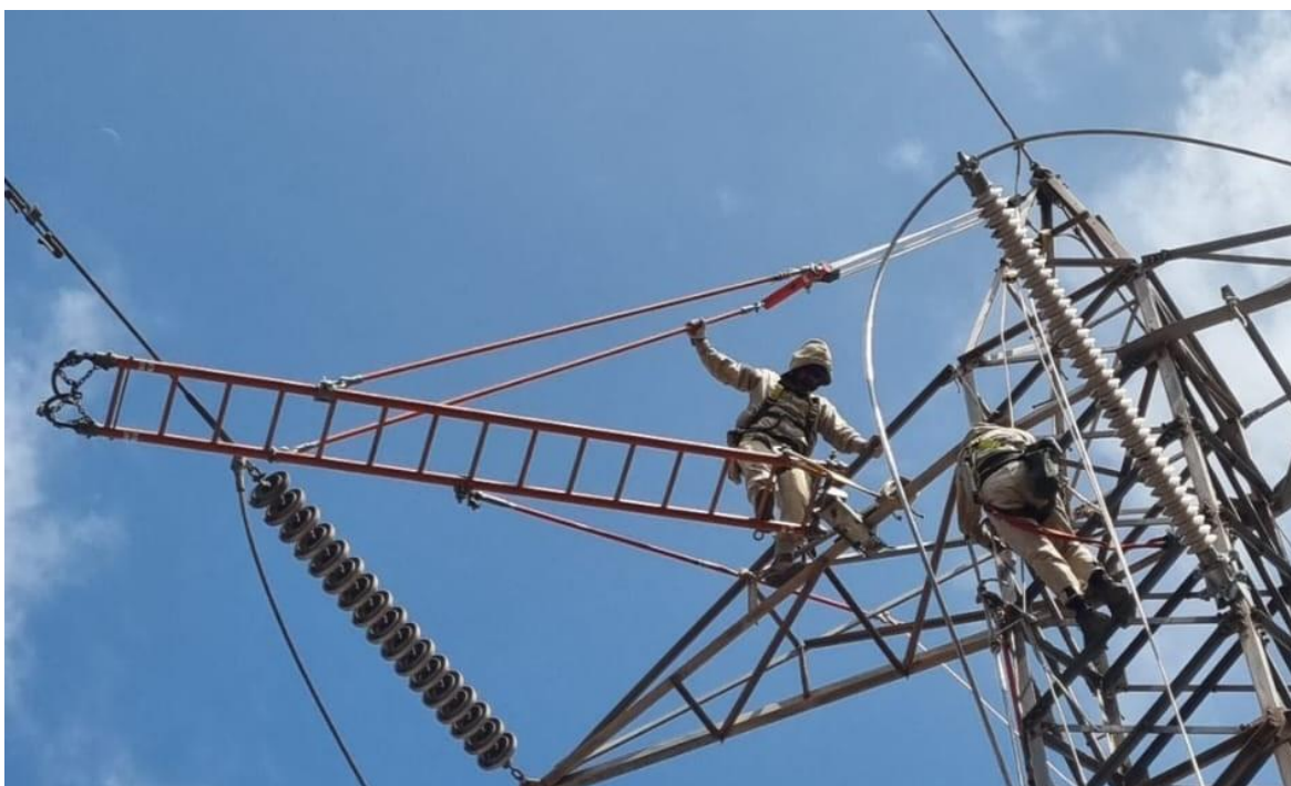
Figura 13: Montaje de equipos previo al evento, en el cual se aprecia la distancia entre eje de soporte y aparejo
