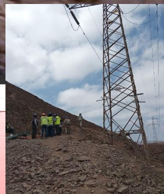
Figura 7: Detalle de pendiente de cerro (79%) en el entorno de base de estructura N° 160
