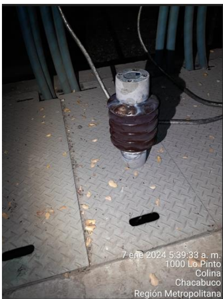
Aislador con descarga
