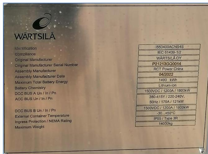
Figura 4.16: Foto de placa módulos de baterías BESS DAS.
