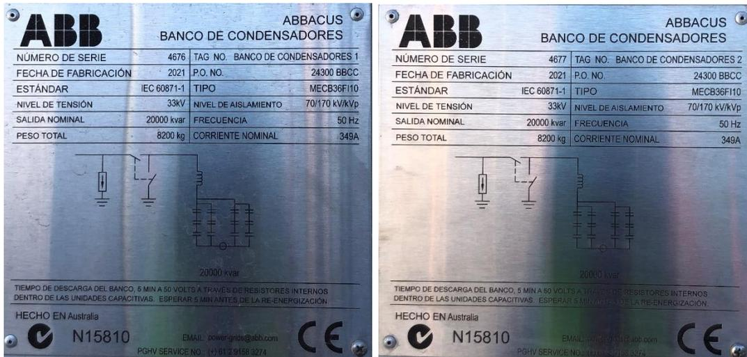
**Figura 6.7: Fotos de placa banco de condensadores.**
