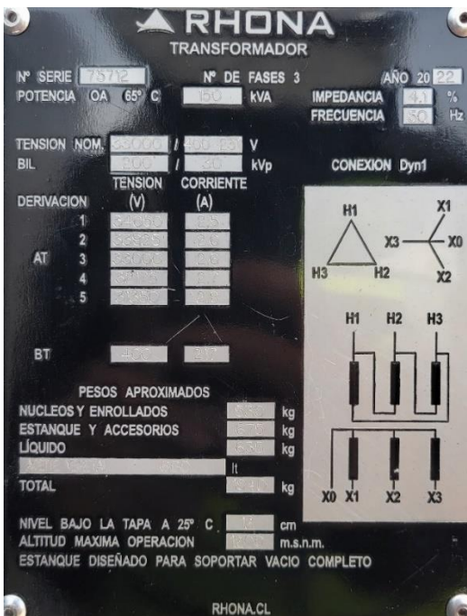
Figura 4.12: Captura de parámetros del Transformadores de SSAA CB4, Fabricante RHONA.
