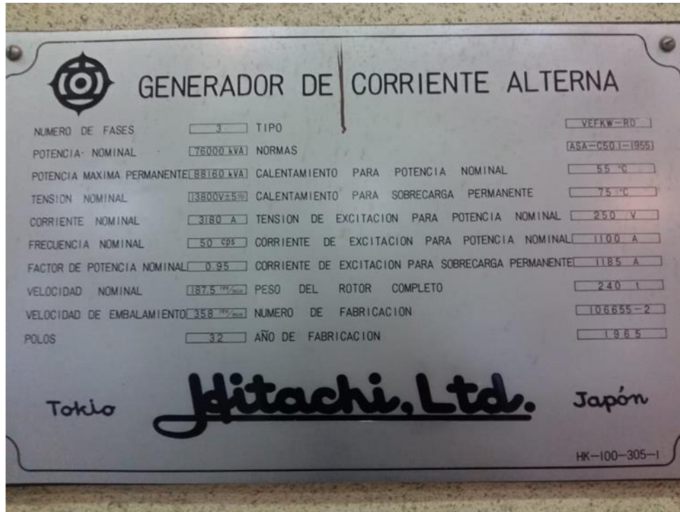
Figura 4.11 – Datos de placa de generador
