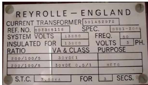
Figura 9.18 – Datos de placa CT – Alimentador 52C19
