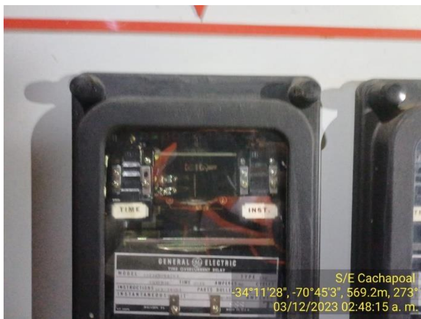
Imagen 2.- Protección de sobre corriente fase A.
