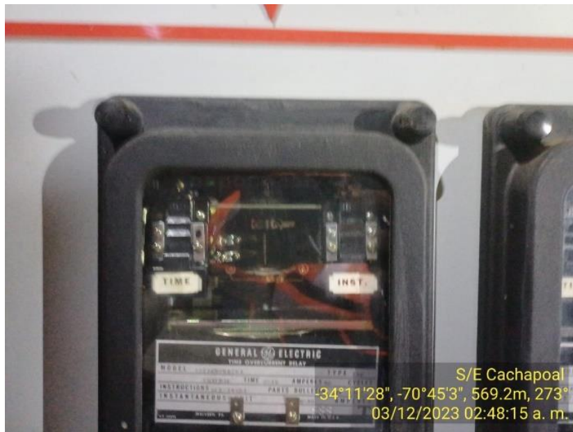
Imagen 1.- Protección de sobre corriente fase A.
