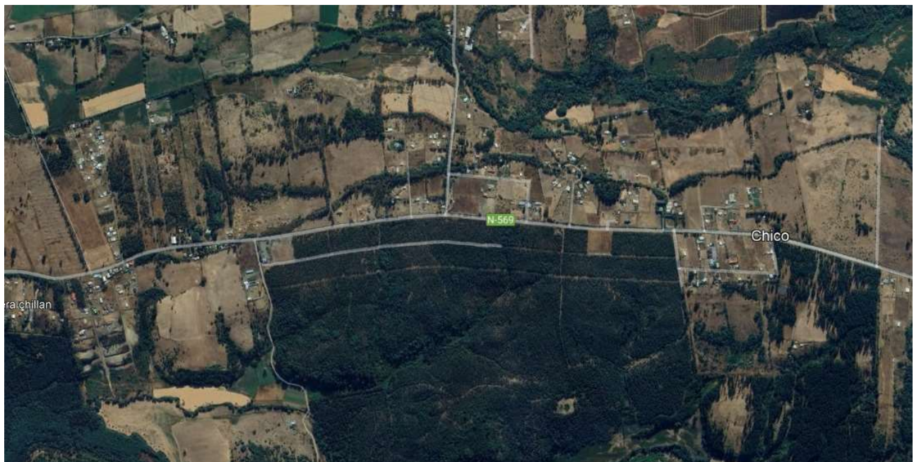
Punto de falla en ruta N – 569. Sector Paso Perales.
