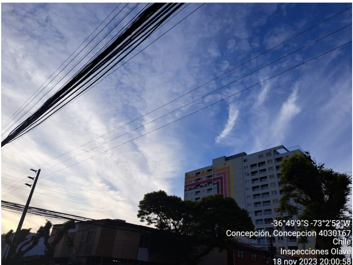
Fotografía N° 3: Registro de conductor y estructura E-32 sin daños para posterior energización.
