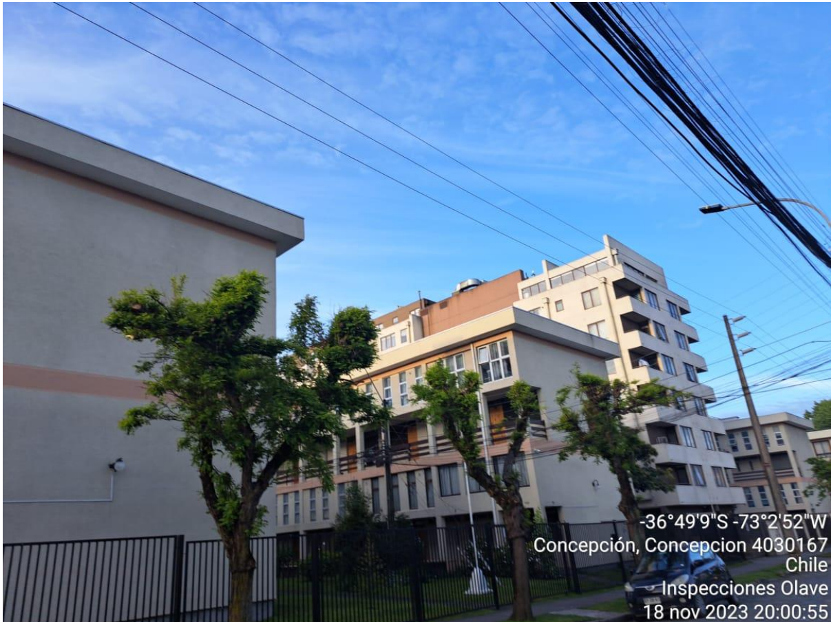
Fotografía N° 2: Registro de conductor y estructura E-31 sin daños para posterior energización.
