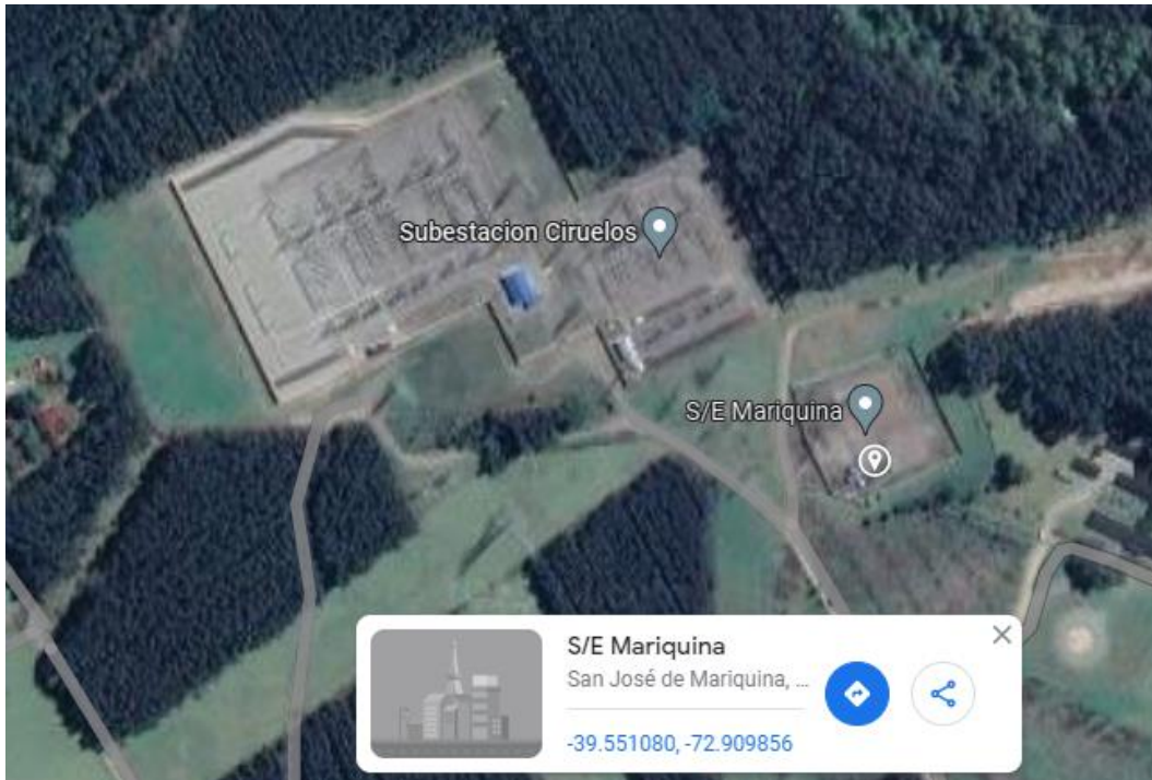
Fotografía Nro. 01: Punto de falla entre transformadores del corriente de paño JT1 y transformador de poder T1 de Subestación Mariquina. Punto geo referencia ( -39.551080, -72.909856).
