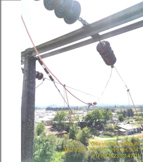
PUENTE FASE CENTRAL NORMALIZADO
