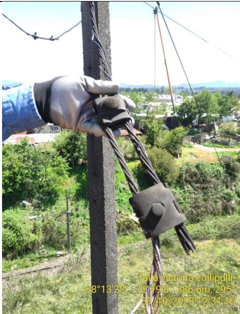
PUENTE FASE CENTRAL
