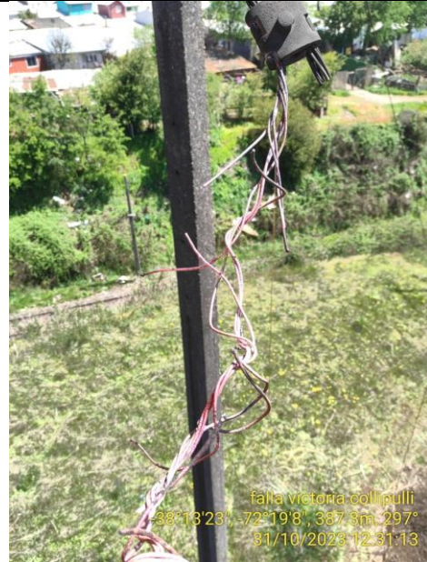
PUENTE FASE CENTRAL
