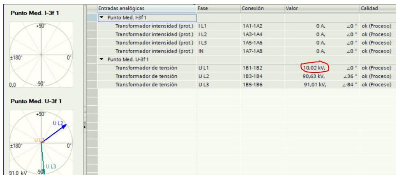
Figura 3. Medidas Análogas del Relé de Protecciones SPAT1-S1 LT Alena – Tap Off Coyanco de 154 kV.
