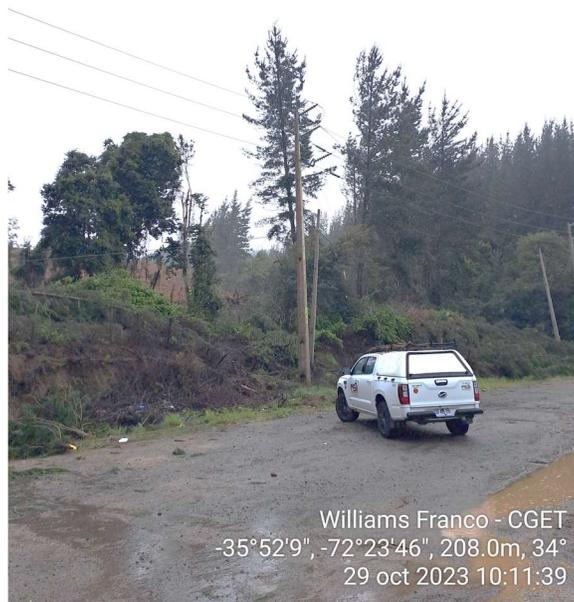
Imagen 5: Volteo de pinos inclinados vano 159-160.
