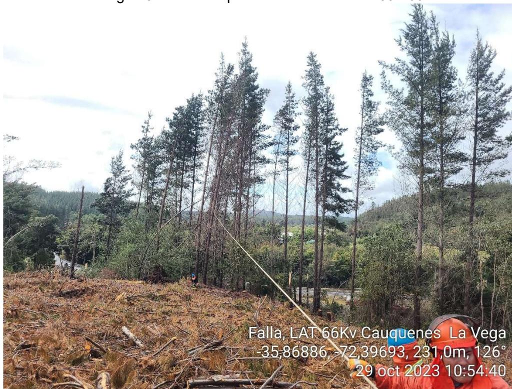
Imagen 6: Trabajos de tala de pinos inclinados vano 160-161.
