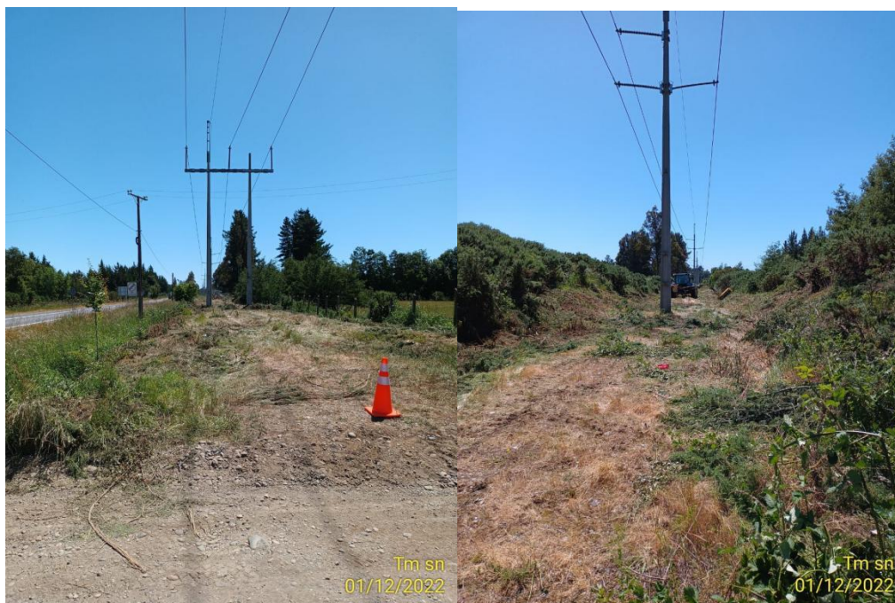
Figura 3: Tramo de trabajo Estructuras 661A a Estructura 666 , en sector Pedregoso, a solicitud de Junta de Vecinos del sector.
