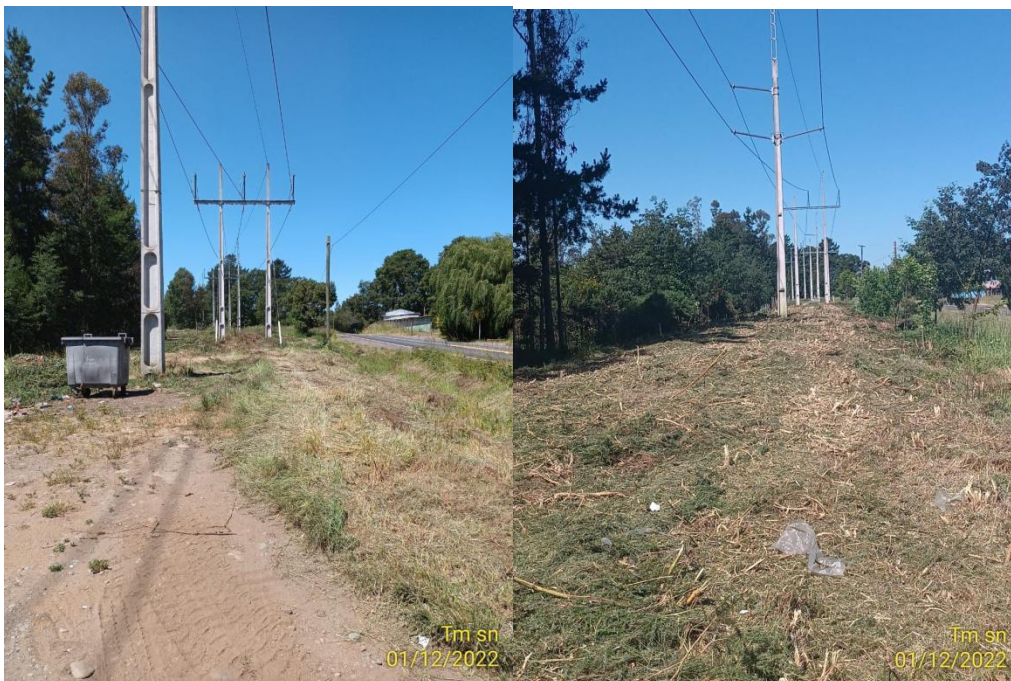
Figura 2: Tramo sector Pedregoso, trabajos entre Estructuras ET 661A a ET 666, distancia aproximada 0,5 km.
