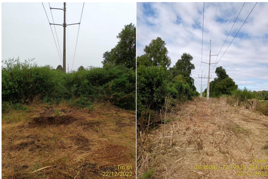
Figura 6: Trabajos en sector los Juanes entre ET 486 Y 481. Se observa matorral muy denso, con camino faja LT totalmente cerrado, condición de trabajo muy pesada, posteriormente se observa el faja con roce
