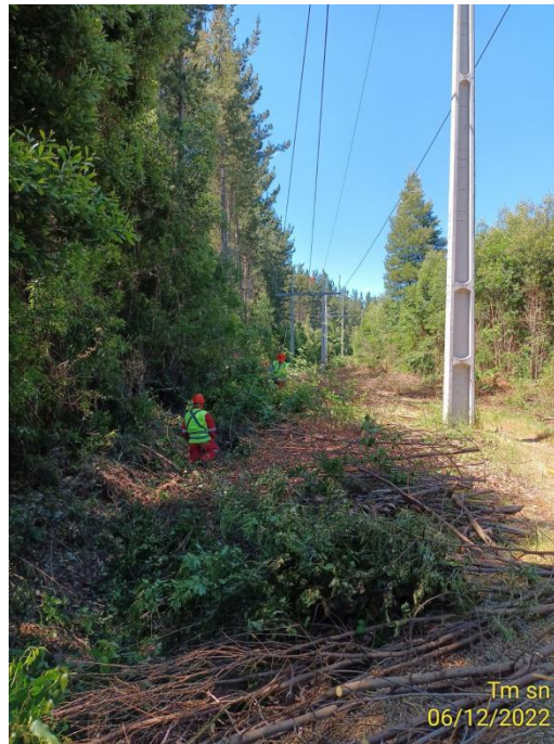
Figura 4: Tramo de trabajo Estructuras 497 a Estructura 494 localidad Los Laureles, sector Trompulo comuna de Cunco. Se realizo actividad de Roce y se retiro material remanente de roces anteriores y desechos de roce actual.
