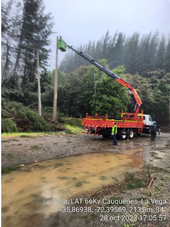
Imagen 8: Instalación de nuevos aisladores horizontales.
