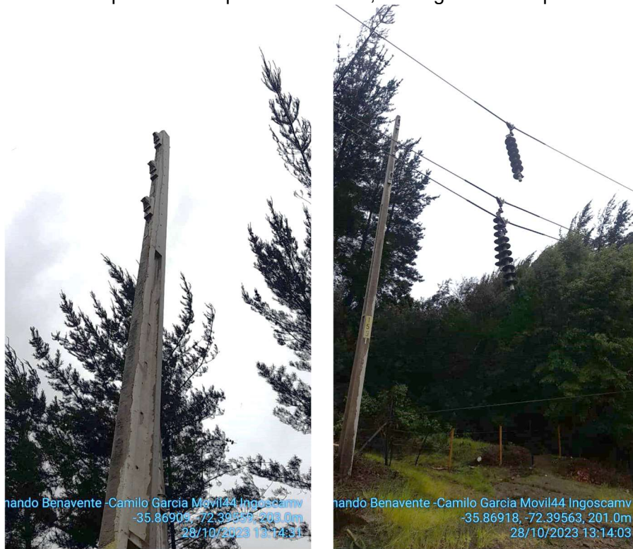
Imagen 6: Estructura 159 dañada.
