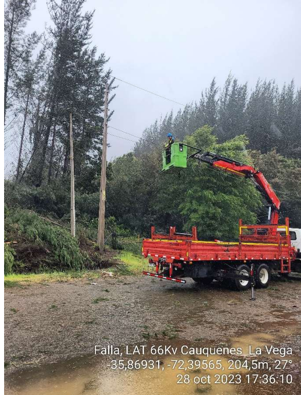
Imagen 8: Instalación de nuevos aisladores horizontales.
