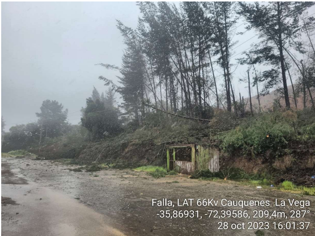
Imagen 2: Punto de falla vano 160-161.
