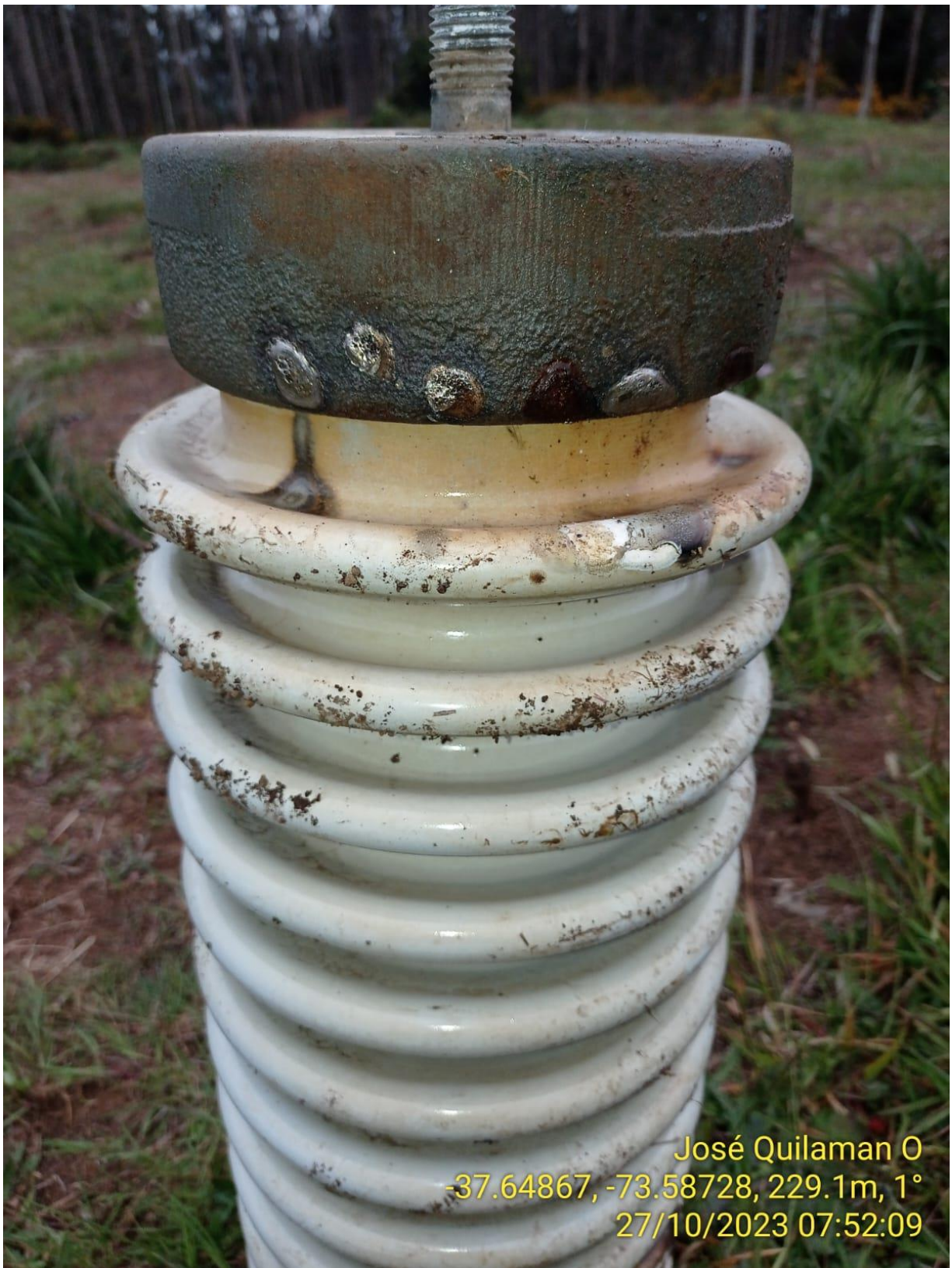
Fotografía N° 2: Line post estructura N° 583 con señales de descarga.
