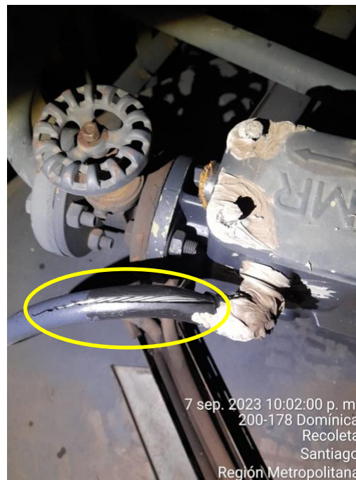
Imagen 2: Cable fisurado
