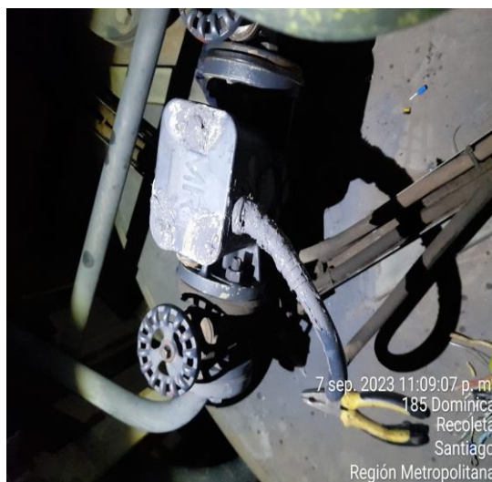
Imagen 3: Limpieza, secado y sellado de caja y cable de control
