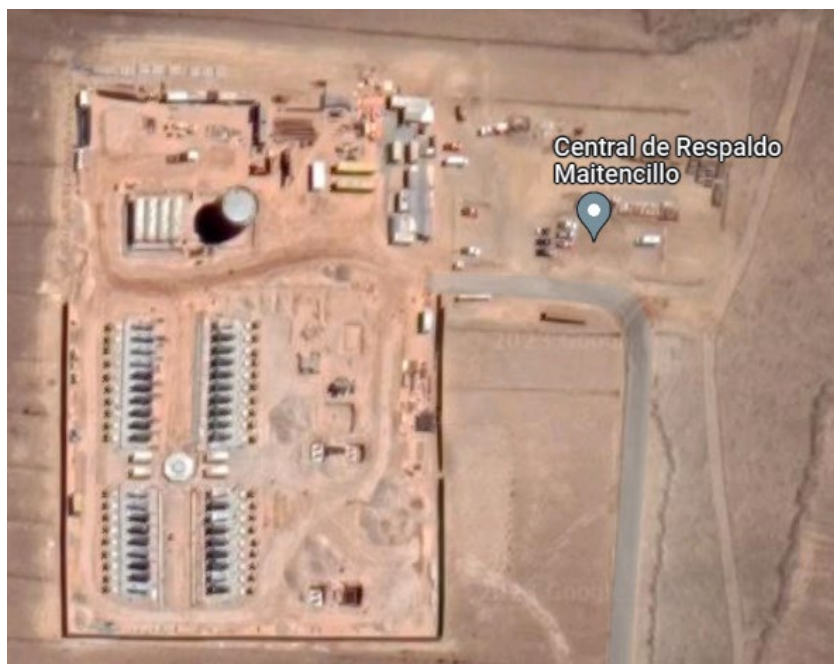
Ilustración 2 Vista aérea de la central
