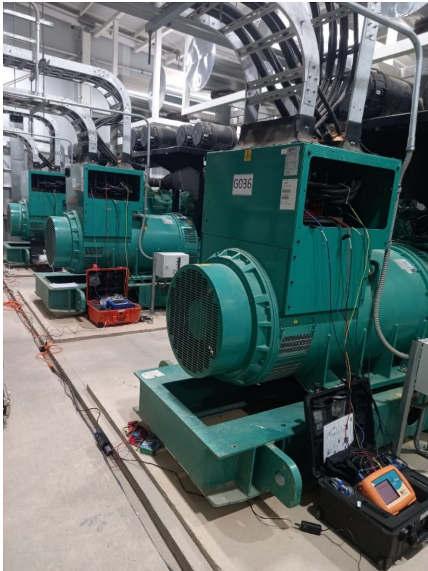
Ilustración 3 Ejecución de PMAX NAVE 4
