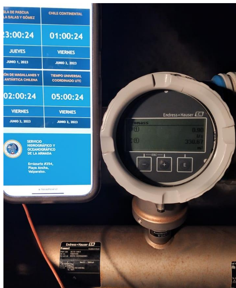
Figura 3: Instalación del flujómetro de combustible
