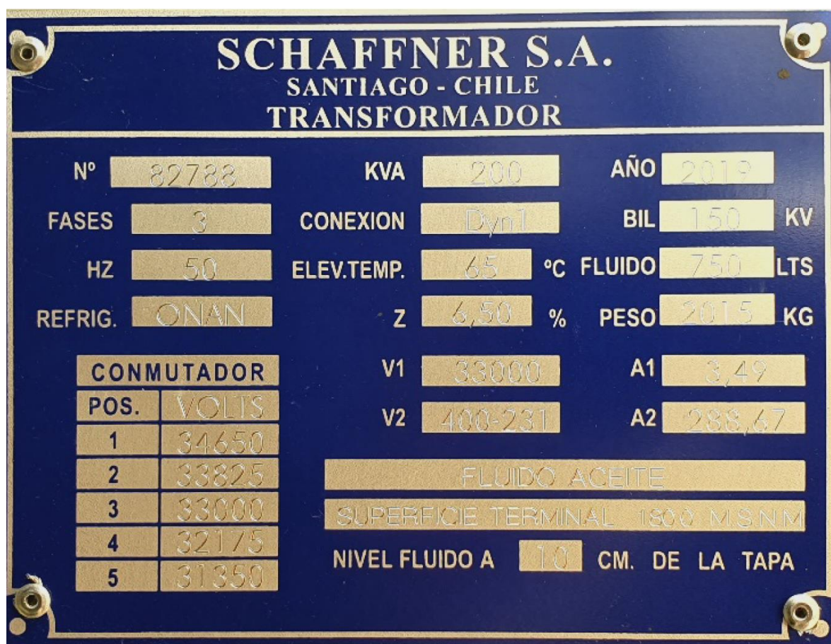
Figura 8.18: Placa de los transformadores de servicios auxiliares de 0.4 kV
