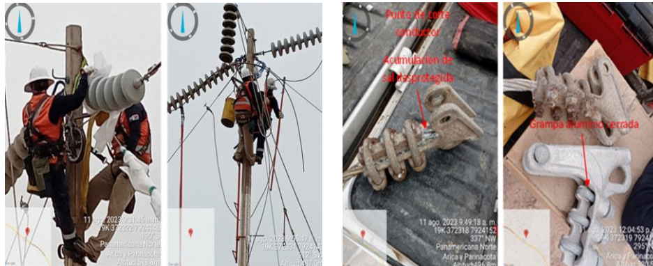
Imagen N°1 y N°2 reparación conductor cortado Estructura N°125
