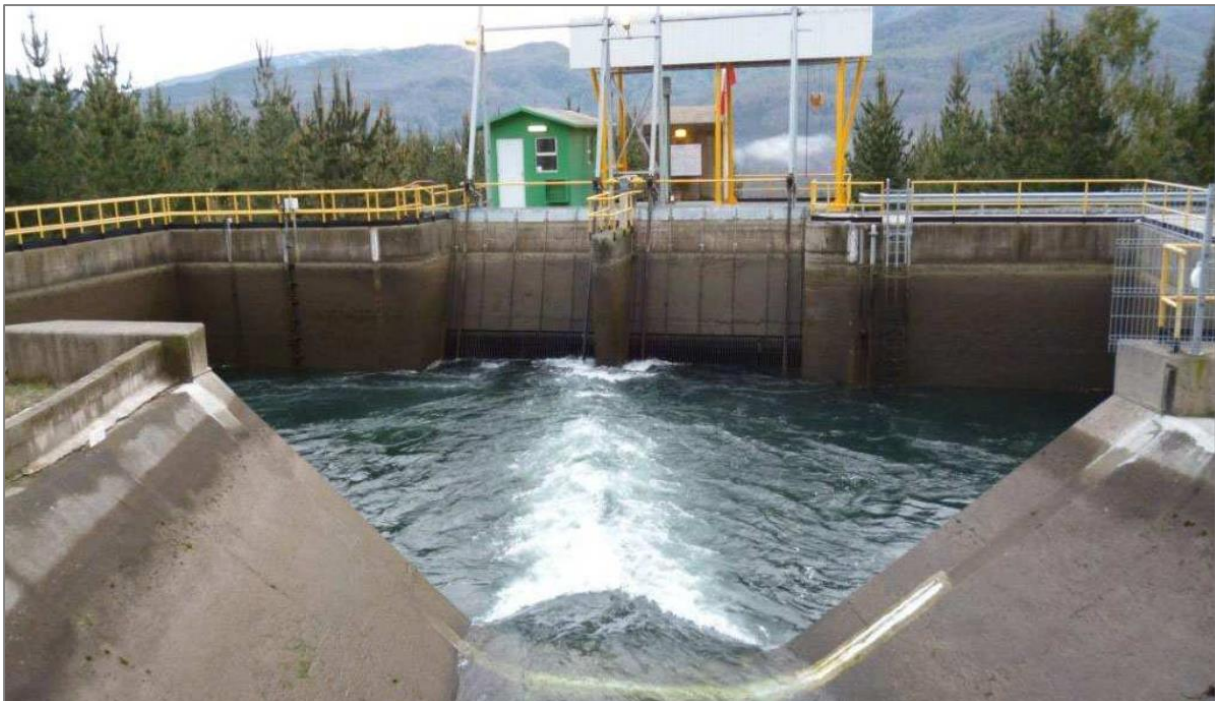
Gráfico 4. Cámara de carga de la CH Mampil.
