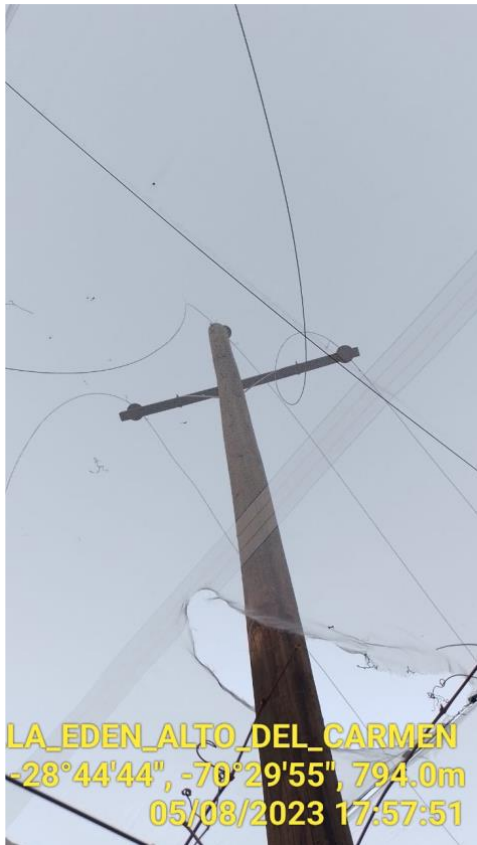
Fotografía N° 7 y 8: Estructura madera M.T. ubicada al interior de parronal.
