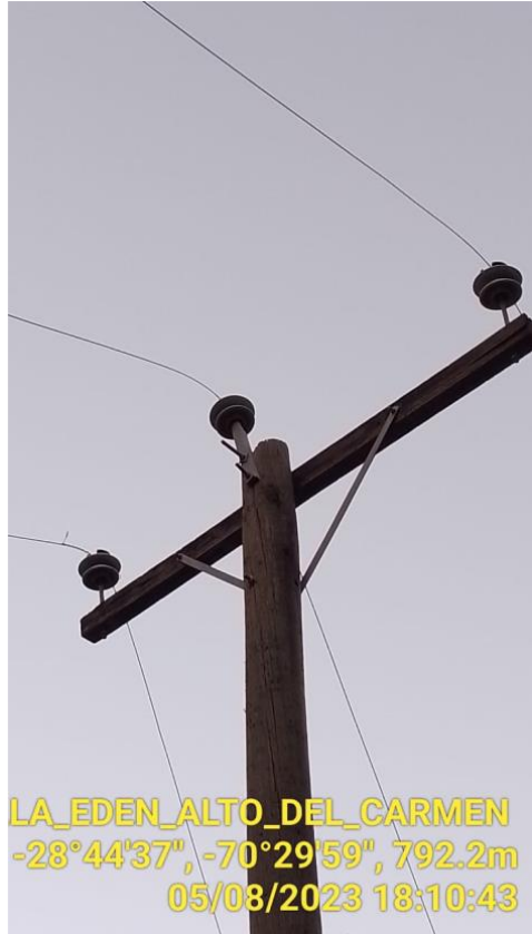
Fotografía Nº 3 y 4: Estructura madera M.T. ubicada en el cerro, cruceta de madera torcida
