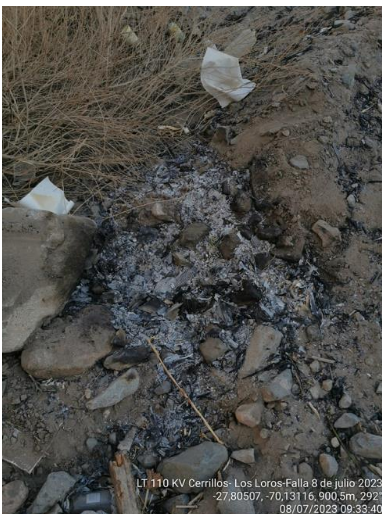
Fotografía N°1_Restos de papeles quemados cercanos al vano estructuras N°154-155
