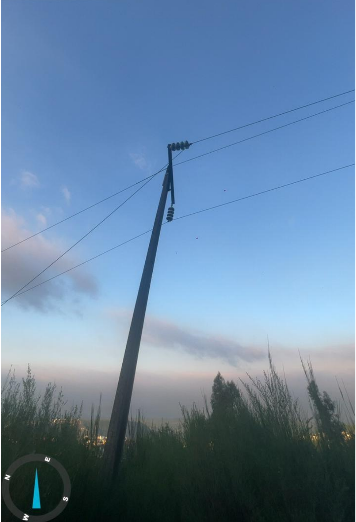
Fotografía N° 4: Estado de la estructura 371 de la línea LT 66KV Curanilahue-Tres Pinos, debido a daños causados por poda de árbol realizada por terceros.
