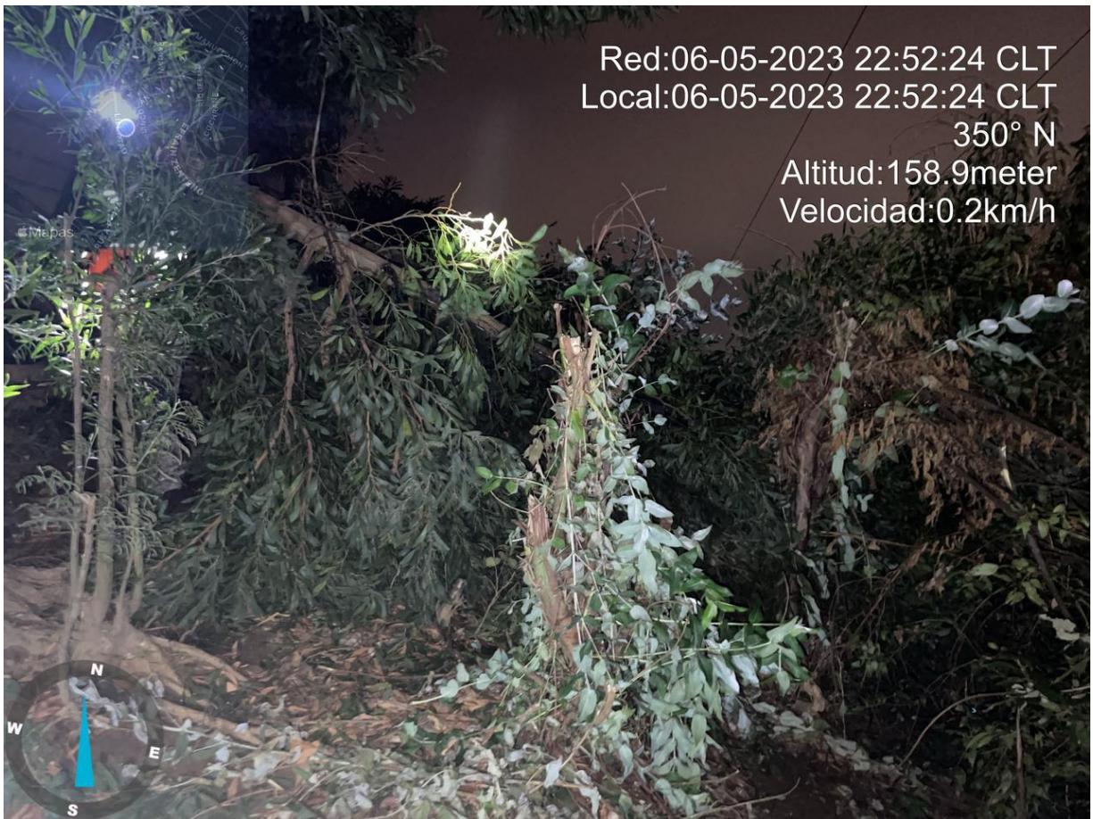
Fotografía N° 2: Resto del árbol podado por terceros (no autorizado ni informado) entre las estructuras 370 y 371 de la línea LT 66KV Curanilahue-Tres Pinos.
