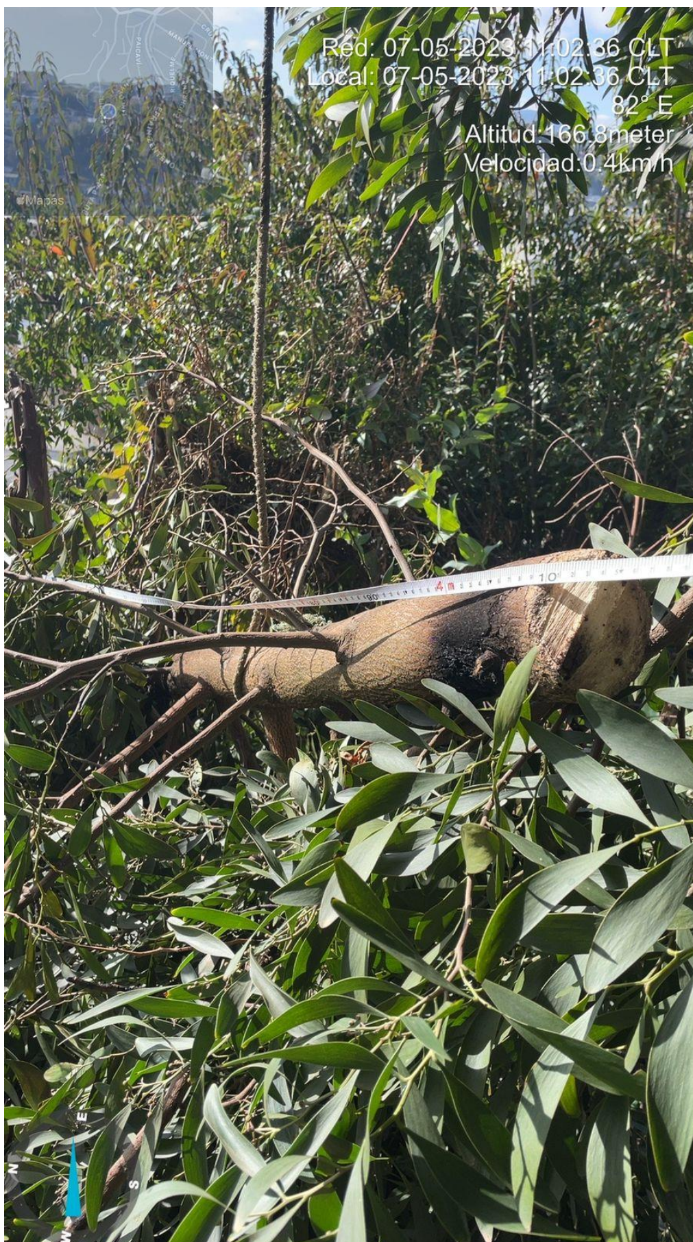
Fotografía N° 1: Resto del árbol podado por terceros (no autorizado ni informado) entre las estructuras 370 y 371 de la línea LT 66KV Curanilahue-Tres Pinos.
