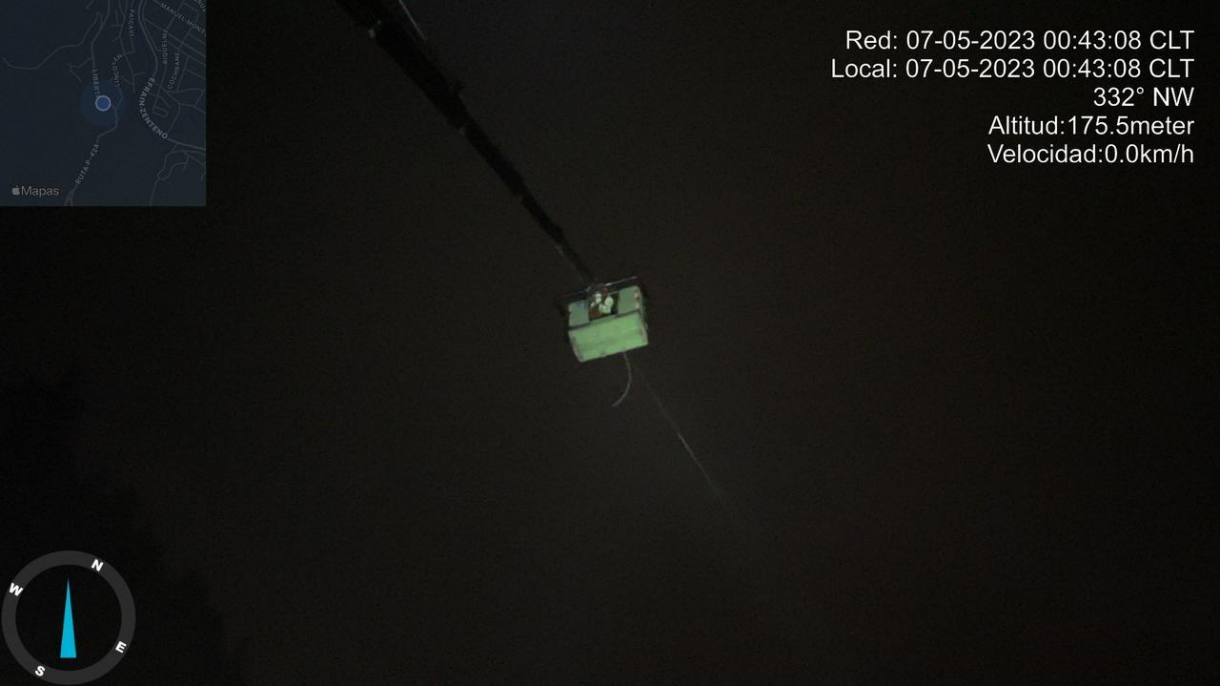
Fotografía N° 6: Reparación del conductor cortado entre las estructuras E170y E171 de la línea LT 66KV Curanilahue-Tres Pinos, debido a daños causados por poda de árbol realizada por terceros.
