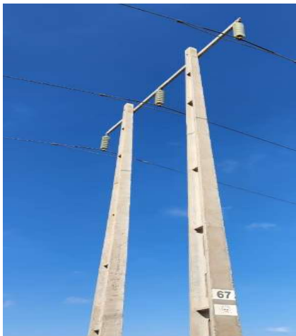
FOTO 03 Aislador contaminado estructura 67
