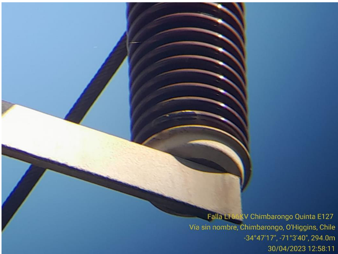
Imagen 2: Aislador Dañado
