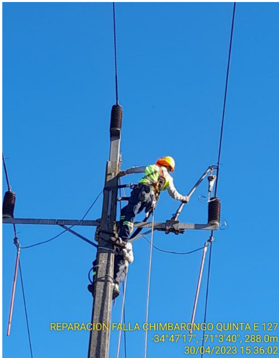
Ilustración 4: Reemplazo de aislador E127.
