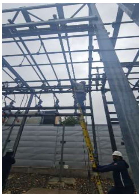
Reparación aislación dañada
