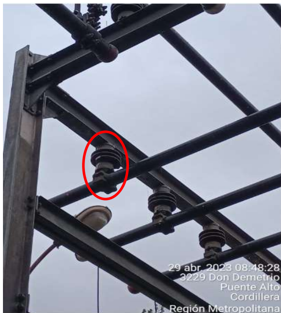
Fotografía 1: Aislación dañada producto del arco eléctrico
