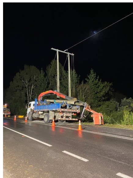
Instalación de Ferretería y normalización de conductores de AT
