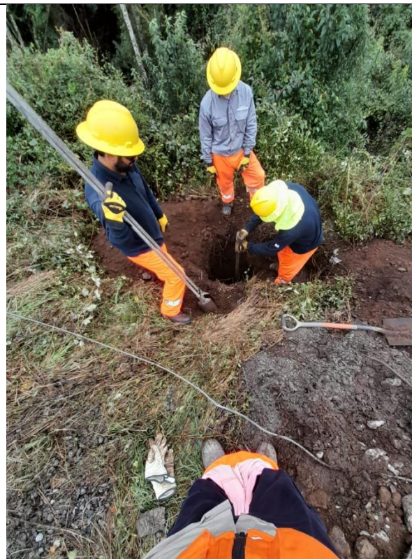
Hoyadura de poste a pulso
