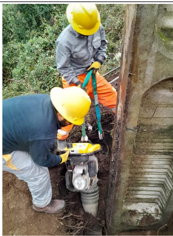
Instalación y compactación de postes nuevos
