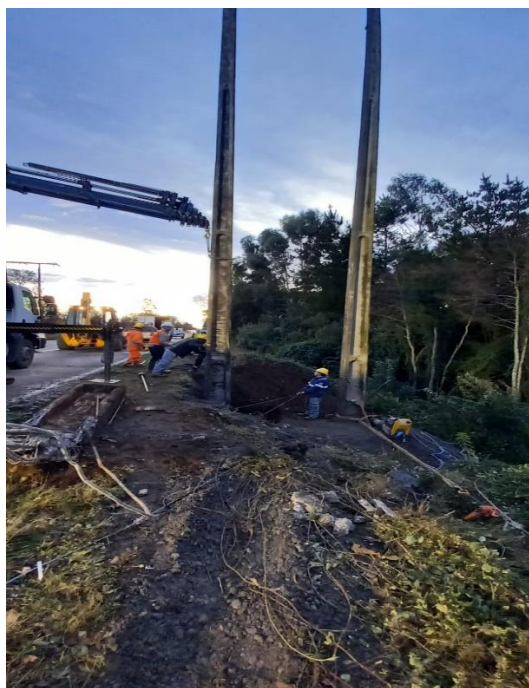
Instalación y compactación de postes nuevos
