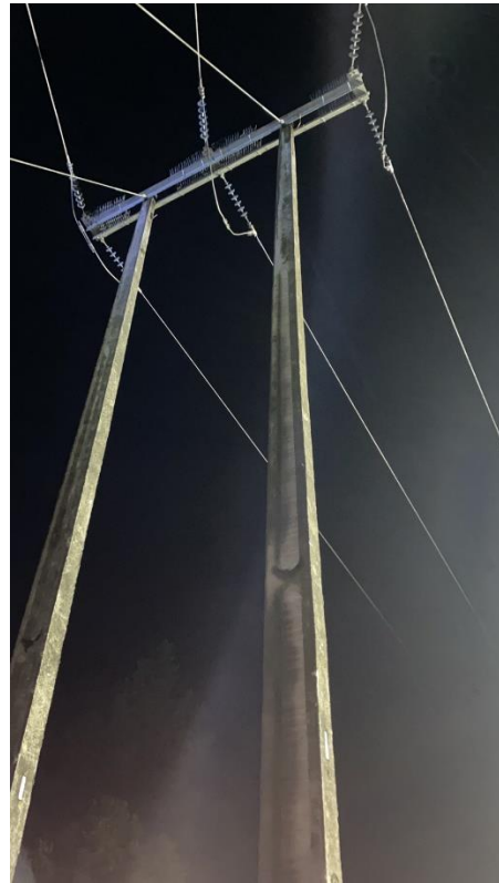
Estructura completa reemplazada
