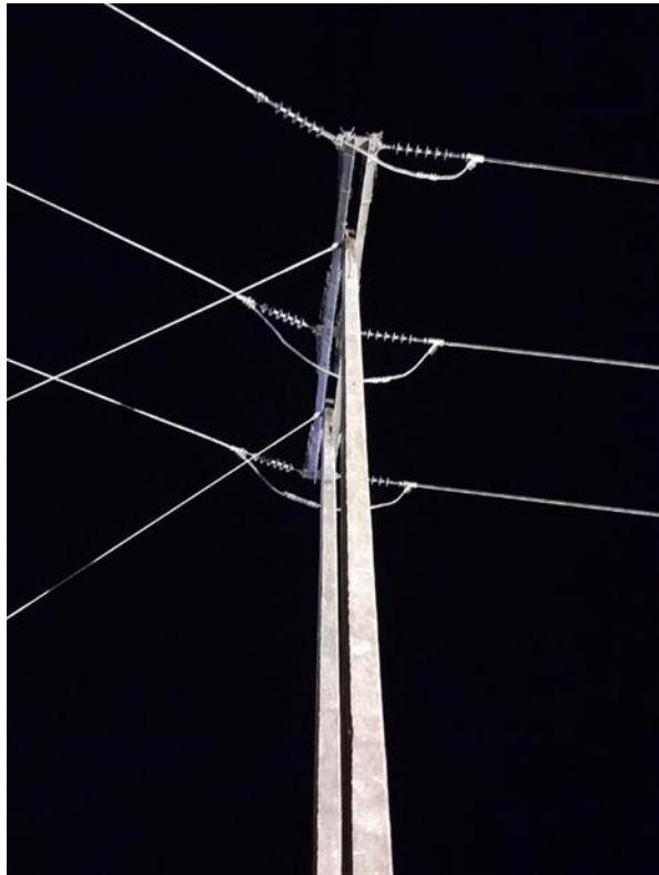
Estructura completa reemplazada
