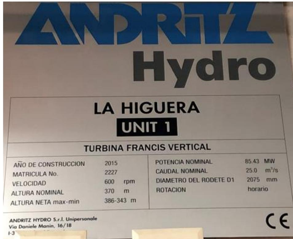
Figura 8.47: Placa de la turbina
