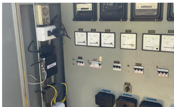
Figura 10 Instrumentos de medida de corriente miden valor 0.
