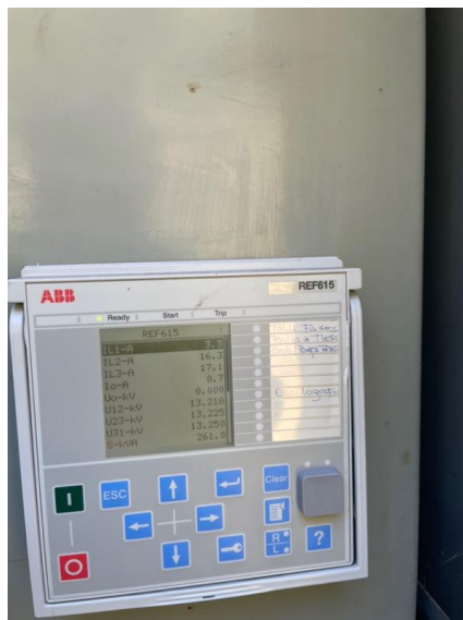
Figura 9 Equipo registrador oscilográfico, mostrando desbalance de corrientes.
