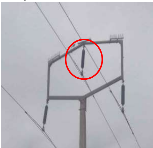
Foto 1: Estructura N°42 L. 110 kV Pan de azúcar – Las compañías: Estructura en la cual se produjo el flash over de la fase superior.
