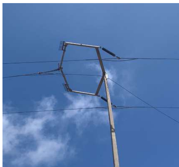
Foto 2: Estructura N° 31 L. 110 kV Pan de azúcar – Las compañías: Estructura en la cual se produjo un daño en la cruceta y reemplazo de poste de hormigón.
