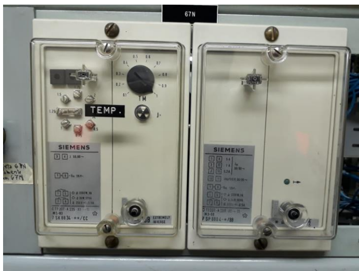
Sistema 1: Función de sobrecorriente direccional residual
