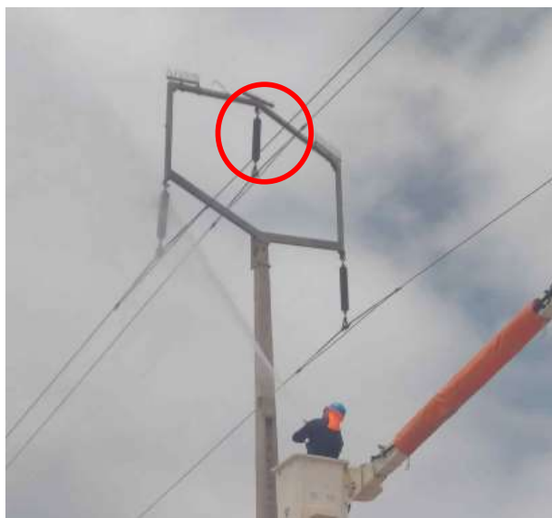
Foto 1: Estructura N°42 L. 110 kV Pan de azúcar – Las compañías: Estructura en la cual se produjo el flash over de la fase superior.
