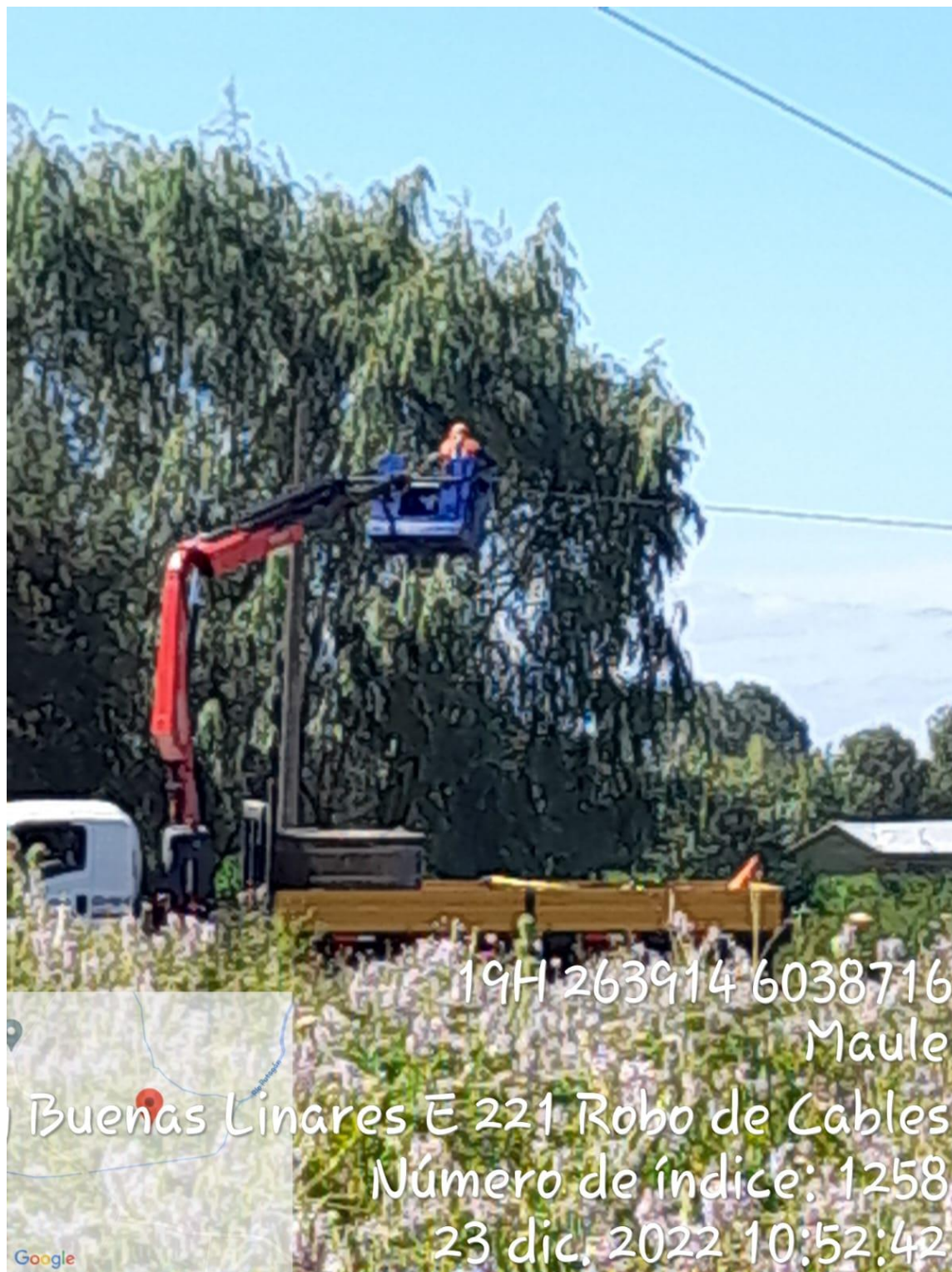
Figura 5: Reparación de los conductores, personal trabajando en la estructura N°221 del tramo de línea Yervas Buenas – Linares 154 kV.
