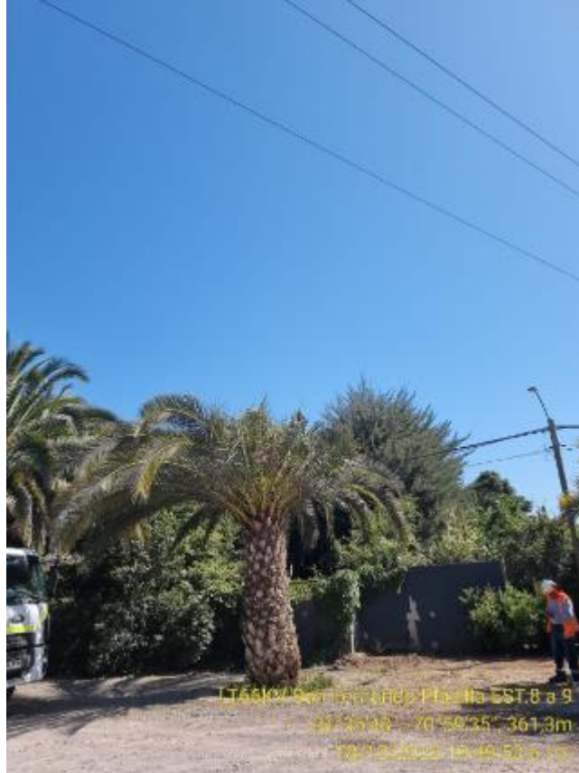
Imagen N°3 , Trabajos de despeje finalizados
