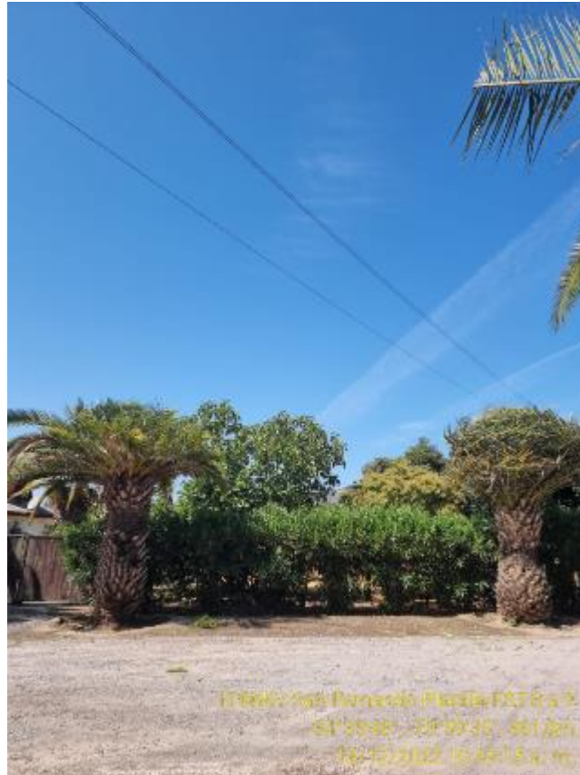
Imagen N°4, Trabajos de despeje finalizados
