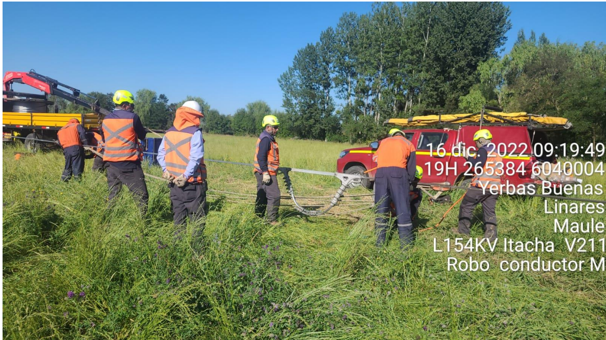
Figura 5: Reparación del conductor, personal trabajando en la estructura N°211 del tramo de línea Yerbas Buenas – Linares 154 kV.
