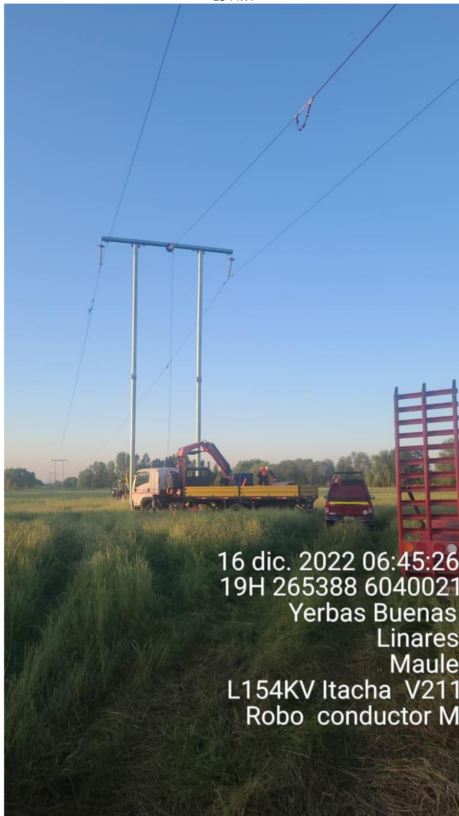
Figura 4: Robo de conductor registrado en la estructura N°211 del tramo de línea Yervas Buenas – Linares 154 kV.
