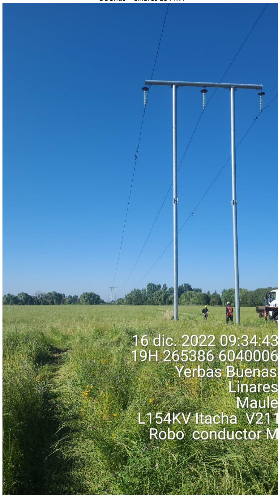
Figura 6: Reparación del conductor, personal trabajando en la estructura N°211 del tramo de línea Yervas Buenas – Linares 154 kV.
