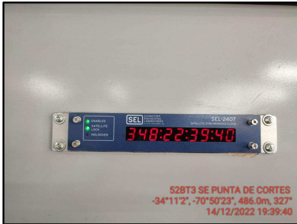
Sincronización horaria de Reloj Satelital de SE Punta de Cortes.
