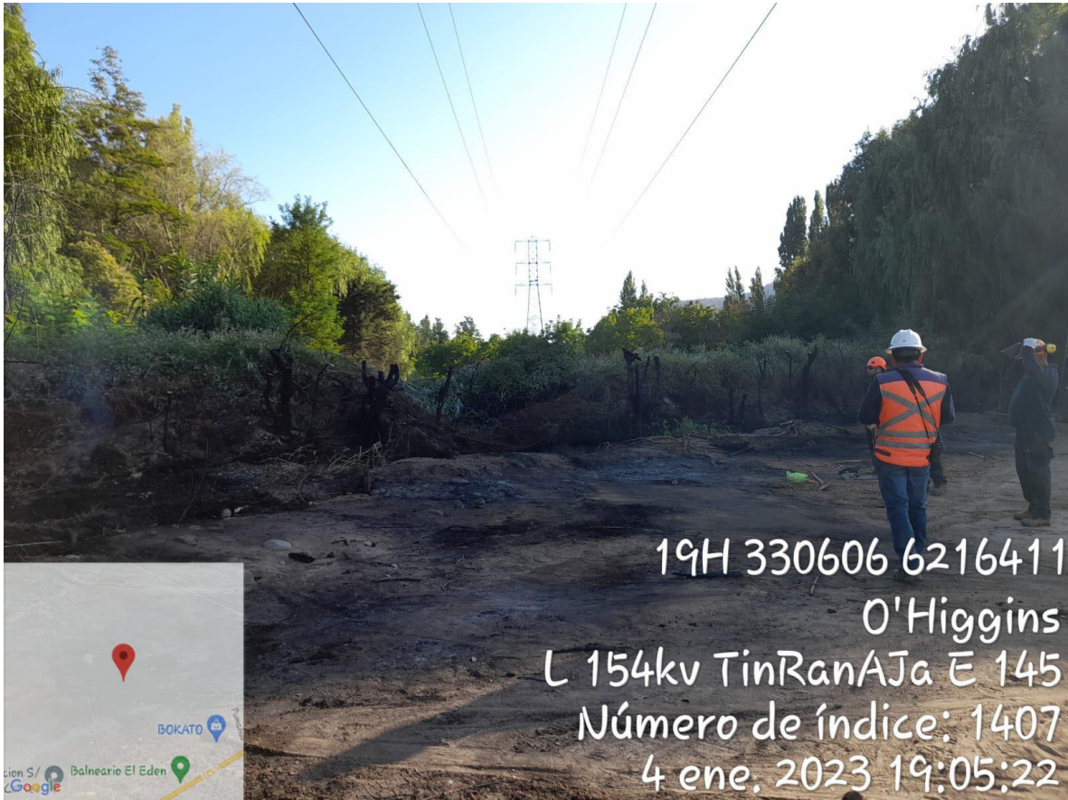
Figura 13. Zona bajo la línea afectada por el incendio
