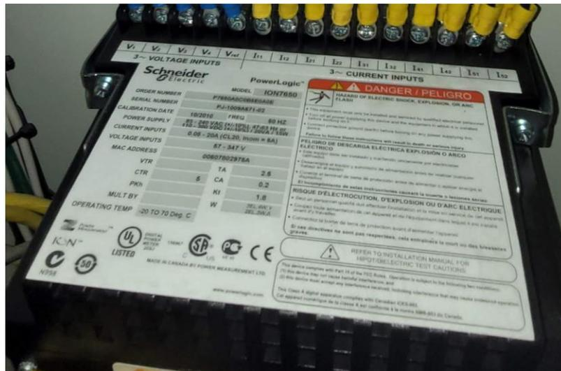
Figura 9.8 – Datos de placa medidor de potencia bruta y factor de potencia - Unidad U3
