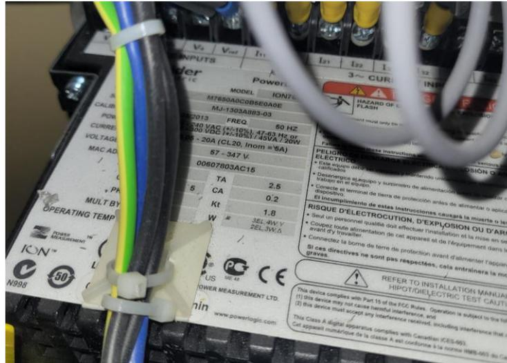
Figura 9.11 – Datos de placa medidor de potencia neta – Trafo Unidad U1
