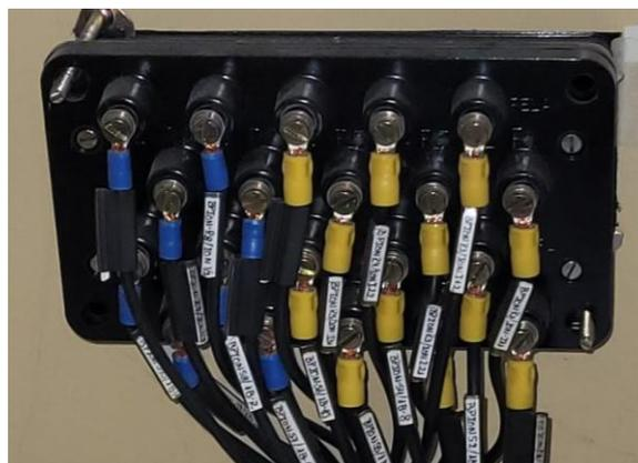
Figura 9.13 – Borneras de conexión
