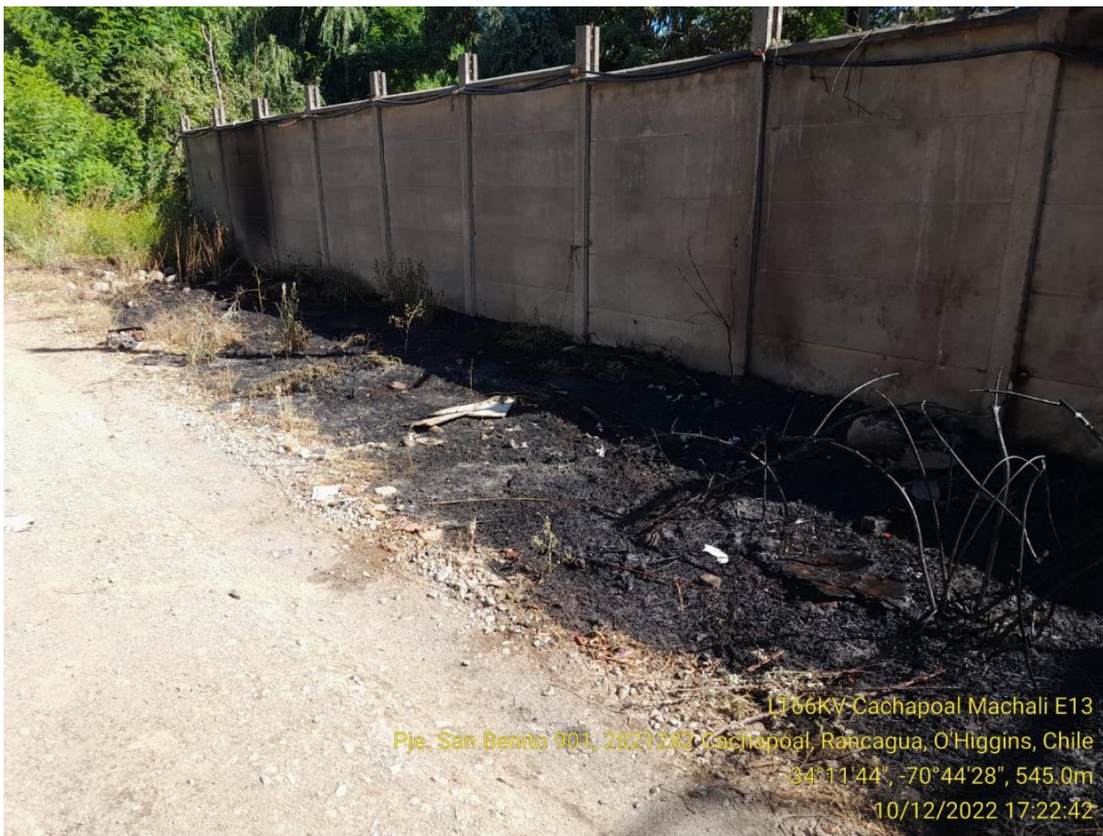
Imagen N°1 , Quema de matorrales provocada por terceros en vano 13-14
