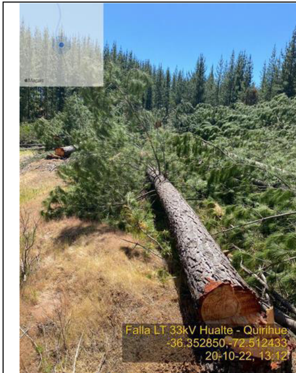
Fig. N°1 Árbol que genero falla en vano 518-519.
