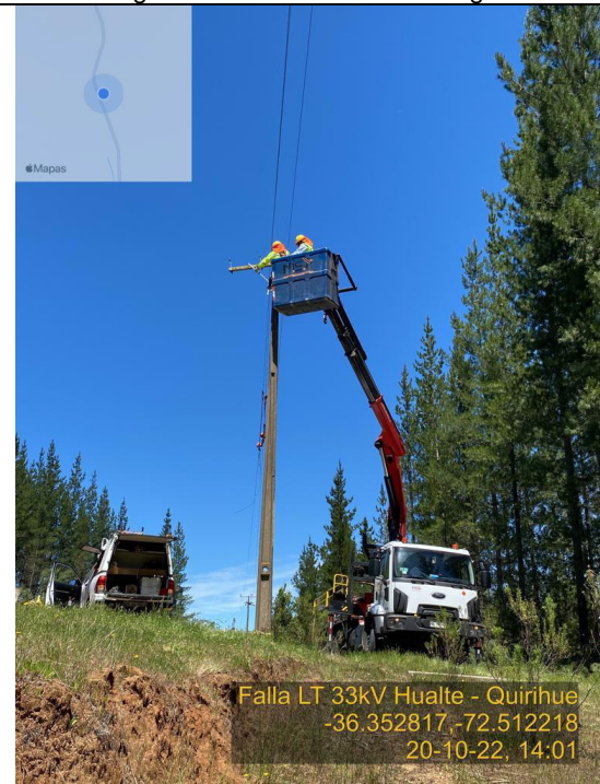
Fig. N°4 Faenas de reparación.
