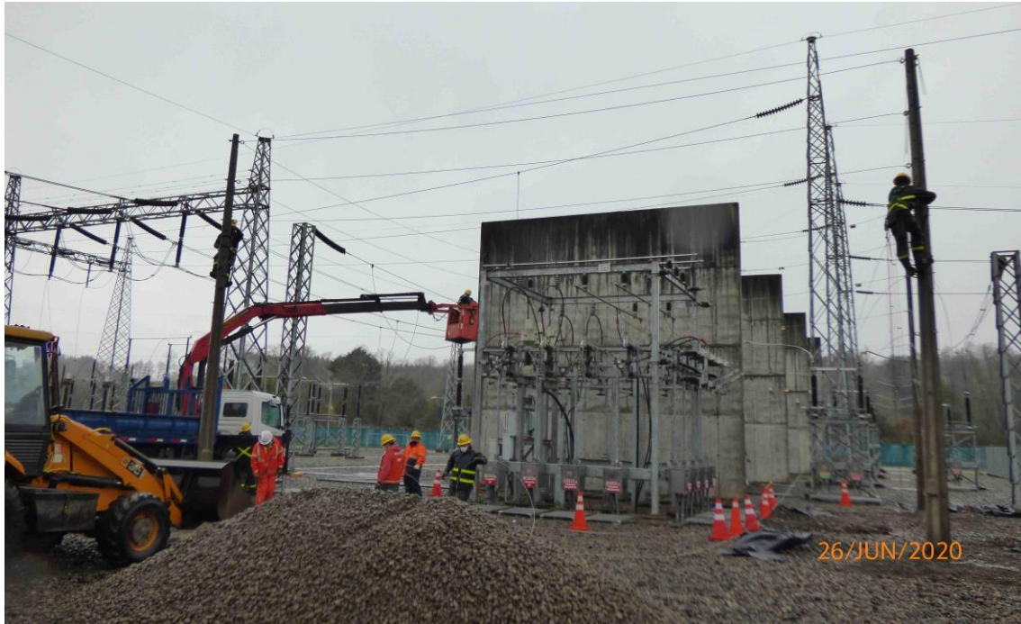
d. Se instaló 39 dispositivos desviadores de vuelo con apoyo de camión grúa y capacho.
