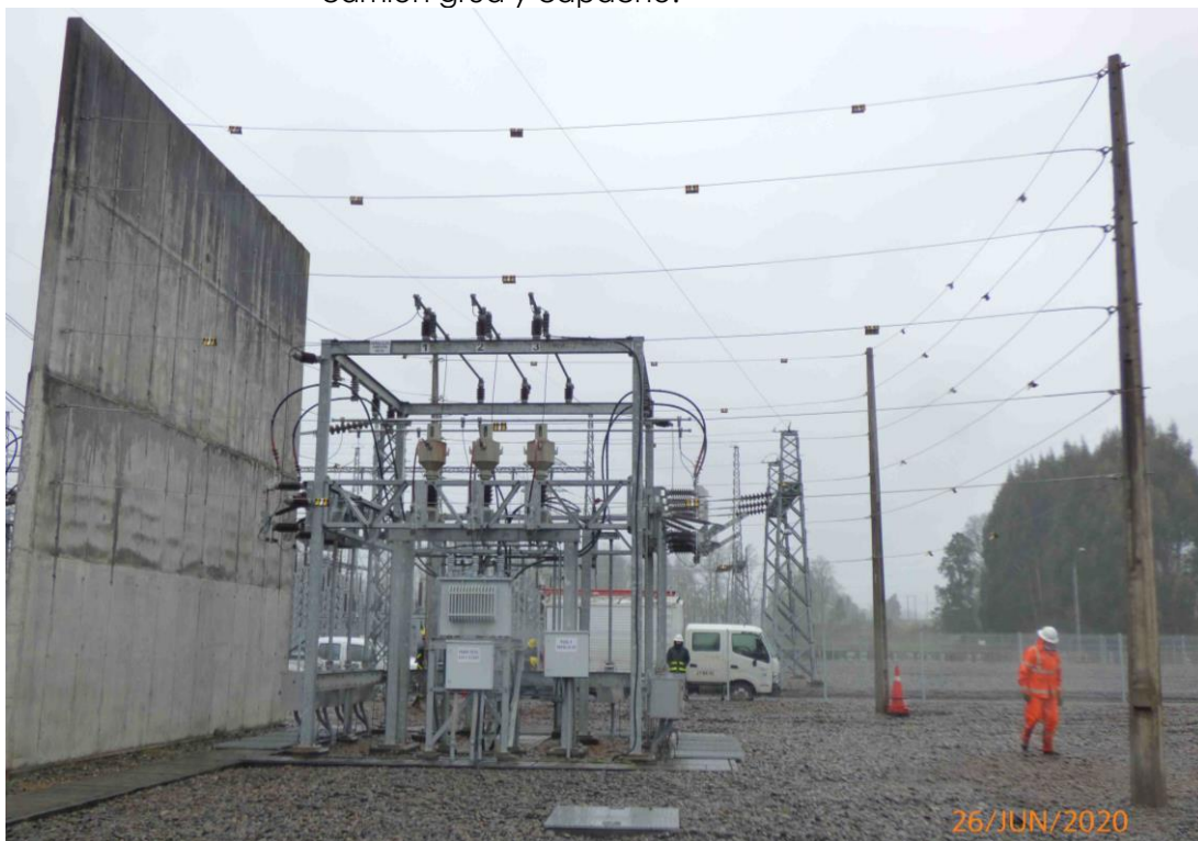
d. Se instaló 39 dispositivos desviadores de vuelo con apoyo de camión grúa y capacho.
