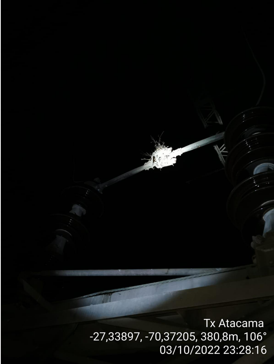
Fotografía N°3. Nido encontrado en 89H1-1, es retirado por personal propio mismo día, antes de normalizar topología.
