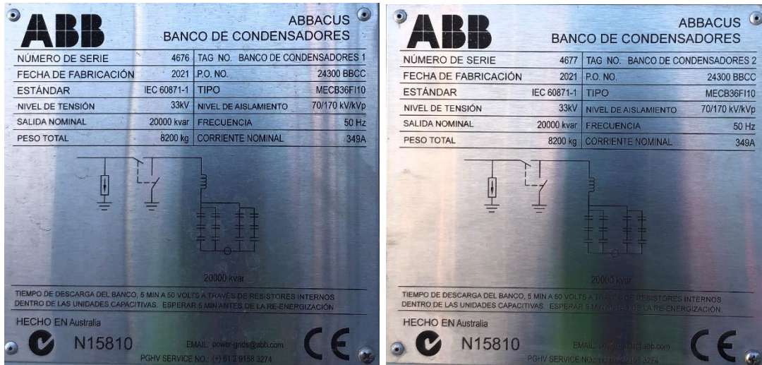
Figura 3.13: Fotos de placa banco de condensadores.
