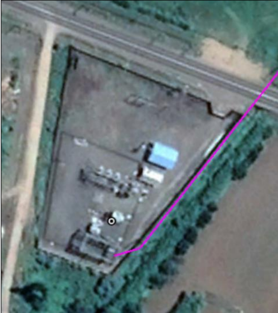
Figura 1-3. Vista aérea S/E Nueva Imperial.
